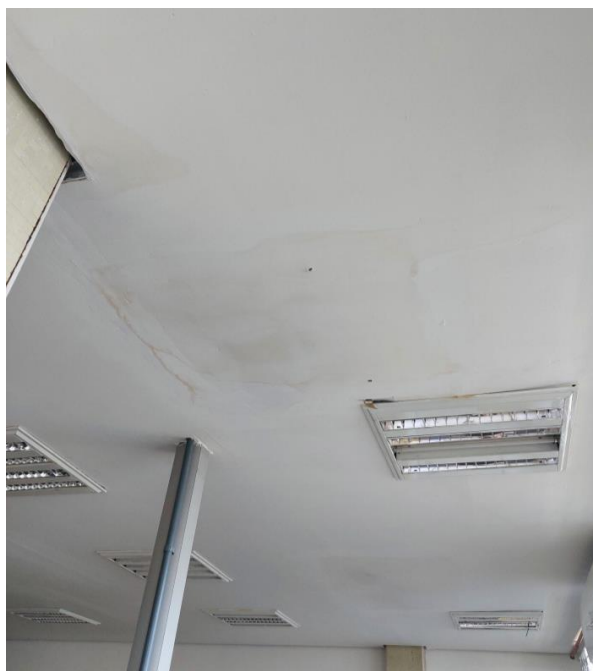
Figura 03: Sala da AJL Procuradores
