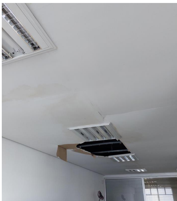
Figura 01: Sala da AJL Procuradores
