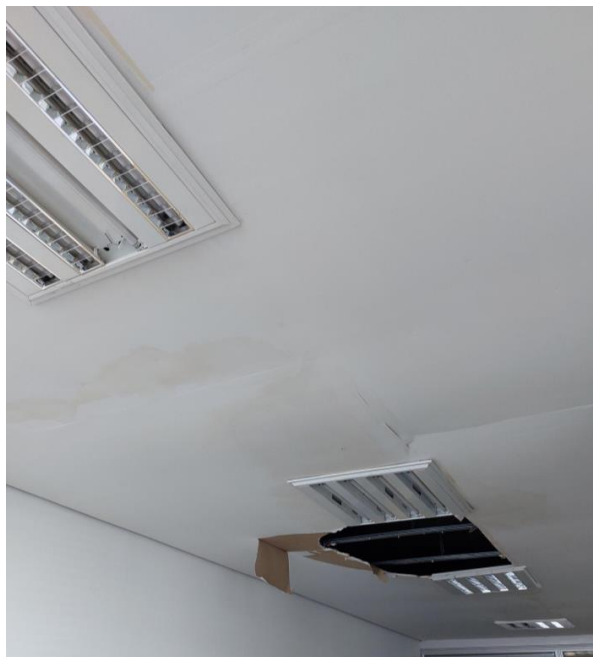
Figura 04: Sala da AJL Procuradores
