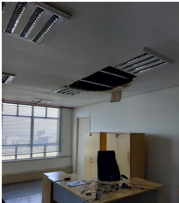
Figura 02: Sala da AJL Procuradores
