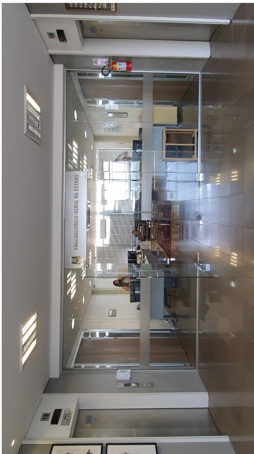
Figura 03. Divisória de vidro temperado com portas duplas no 18º pavimento, referência do serviço a ser executado.
