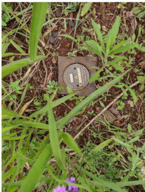
Figura 8 - Implantação do marco M01.
