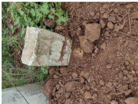
Figura 13 - Implantação do marco de referência de nível RN01.
