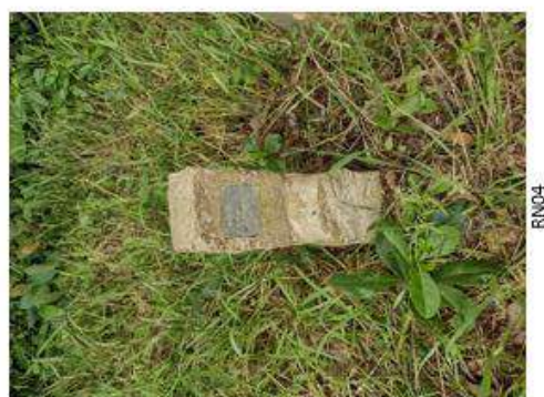
Figura 10 - Implantação do marco de referência de nível RN04.
