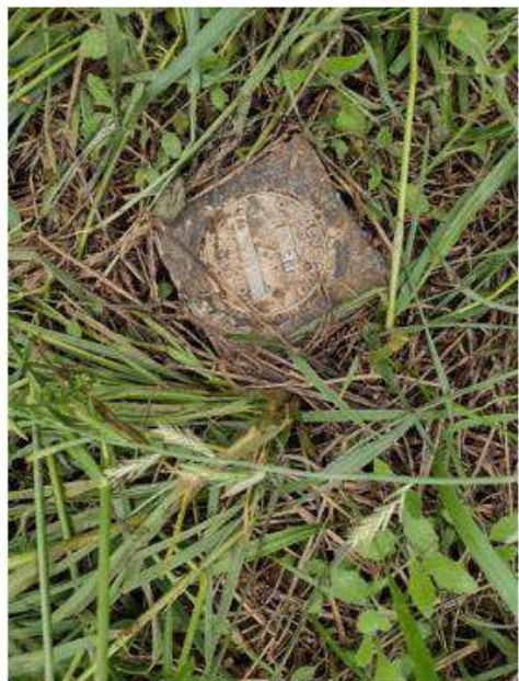
Figura 14 - Implantação do marco M03.
