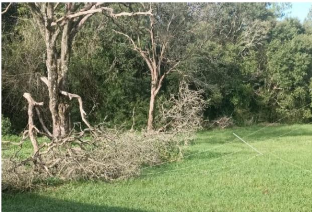
Figura 2 - Árvore caída sobre a rede elétrica, já consertada
