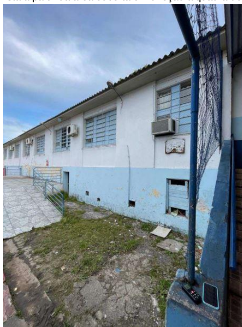
Foto 7: Vista a partir da área coberta em direção à quadra de esportes. Detalhe do muro existente para instalação de guarda-corpo e corrimão
