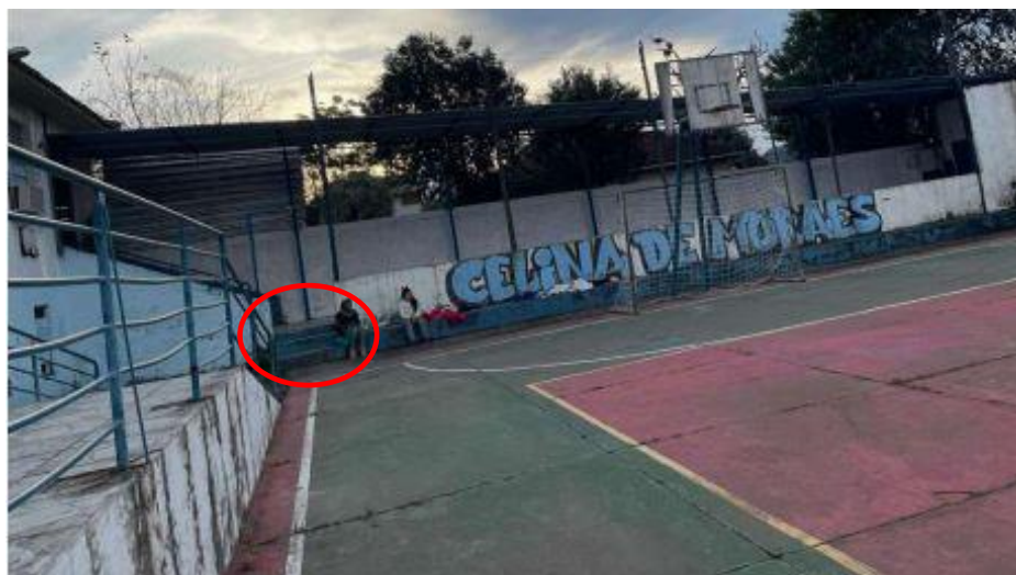
Foto 8: Vista a partir da quadra de esportes: vista do desnível entre a área coberta e o piso do entorno da quadra.
