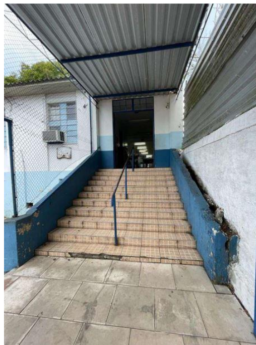
Foto 3: Detalhe da escada e muro lateral (à direita) a demolir e guarda-corpo a remover. Cobertura a manter.
