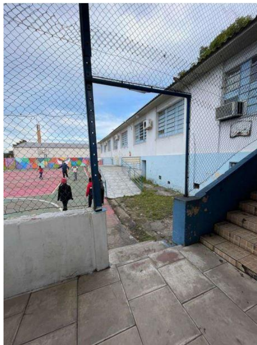
Foto 6: Vista a partir da área coberta em direção à quadra de esportes.
