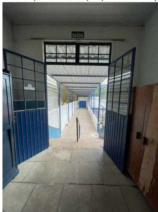
Foto 5: Vista a partir do corredor da escola: detalhe da esquadria a remover para posterior pintura e reinstalação.
