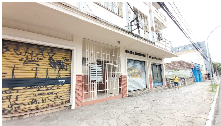
Figura 1: vista externa av. Bento Gonçalves
