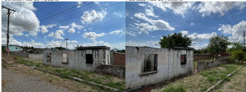
Fachada Rua da Olaria
