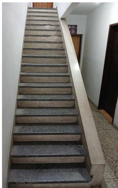
Imagem 1: Escadaria entre os pavimentos.
