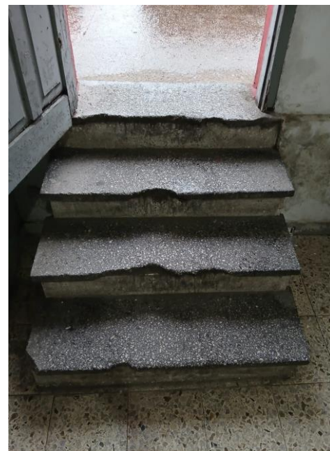
Imagem 2: Escada de acesso.
