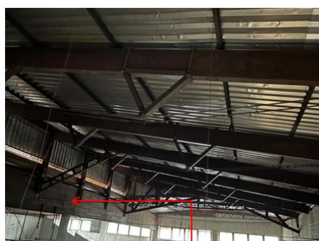
VIGA RETIRADA, SUBSTITUÍDA POR VIGA TRELIÇADA
