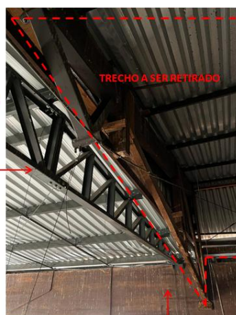
VIGA RETIRADA, SUBSTITUÍDA POR VIGA TRELIÇADA
