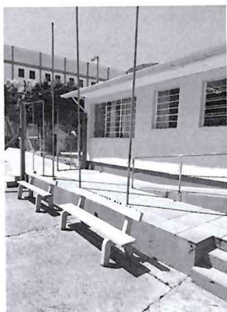
F03: Acesso Principal/Cobertura
