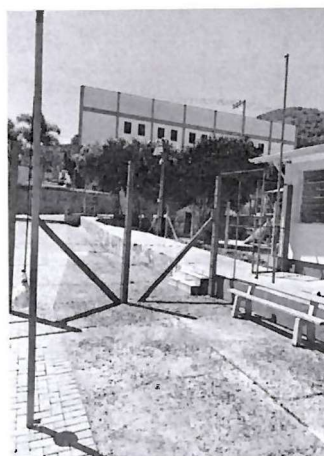
F04: Acesso Principal/Cobertura
