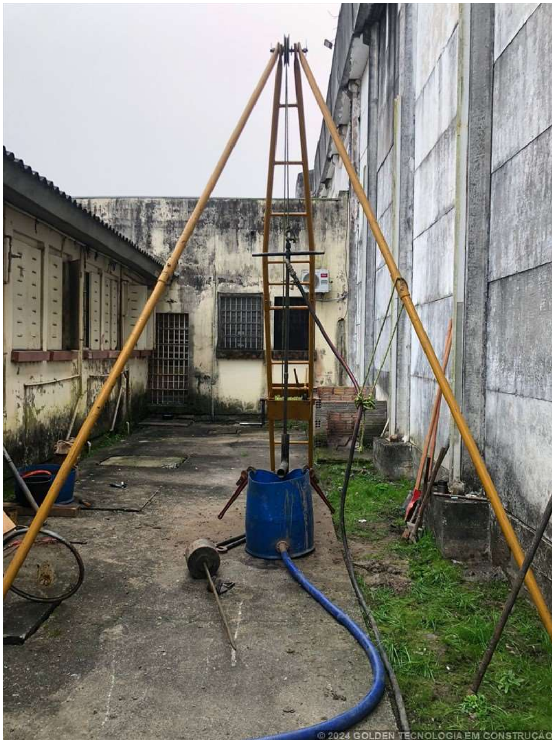
Foto 1 – SP 10 - ESTRADA AFONSO CARDOSO,2000,ZONA RURA - OSÓRIO-RS - 11.09.24
