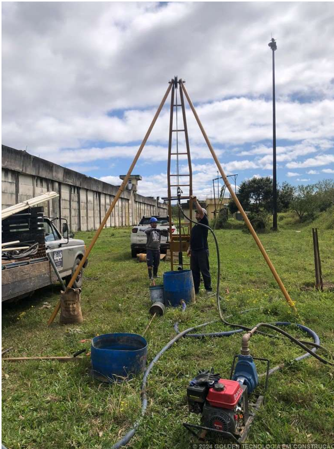
Foto 1 – SP 05 - ESTRADA AFONSO CARDOSO,2000,ZONA RURA - OSÓRIO-RS - 02.09.24
