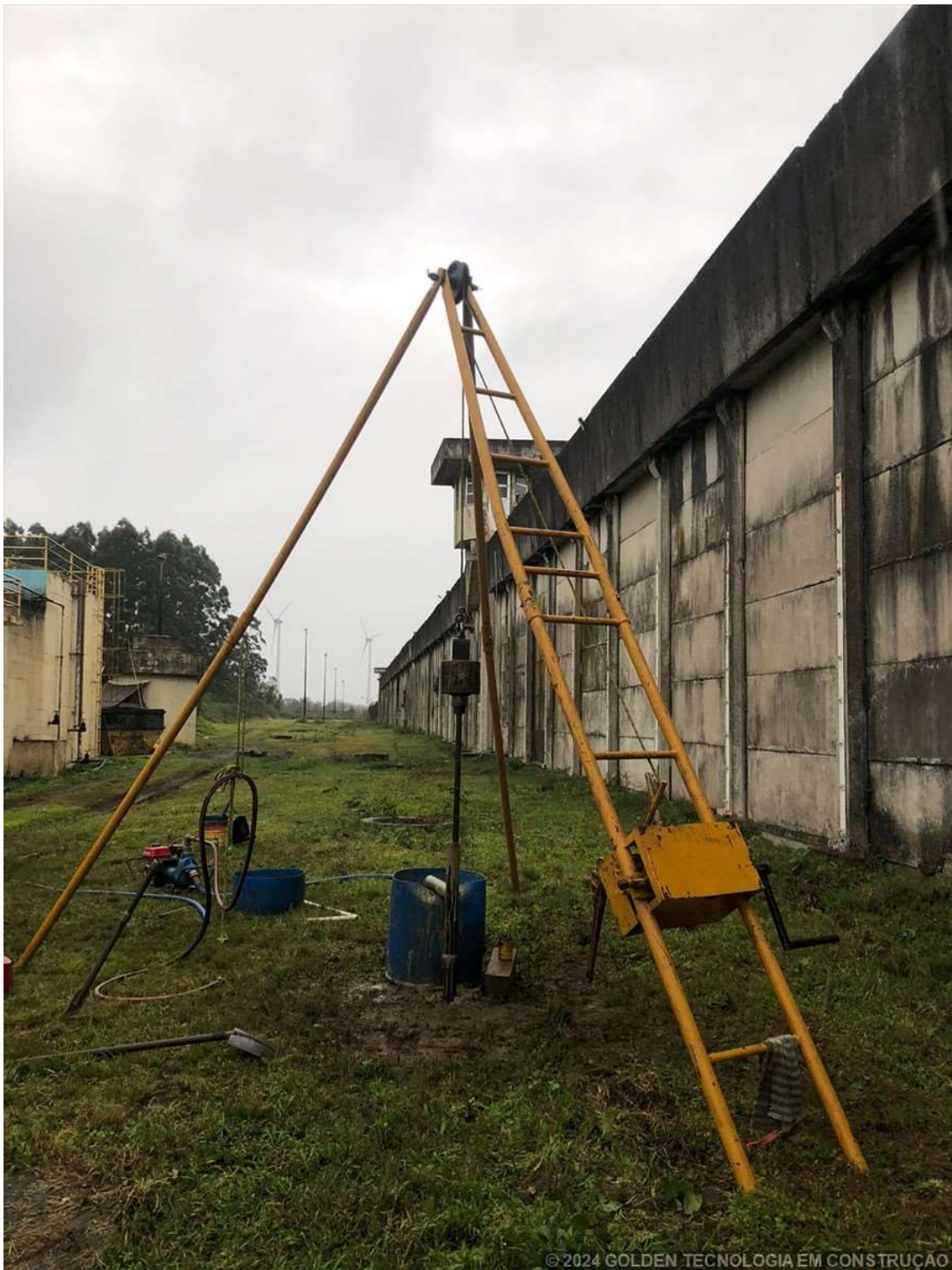
Foto 1 – SP 12 - ESTRADA AFONSO CARDOSO, 2000, ZONA RURA - OSÓRIO - RS - 12.09.24
