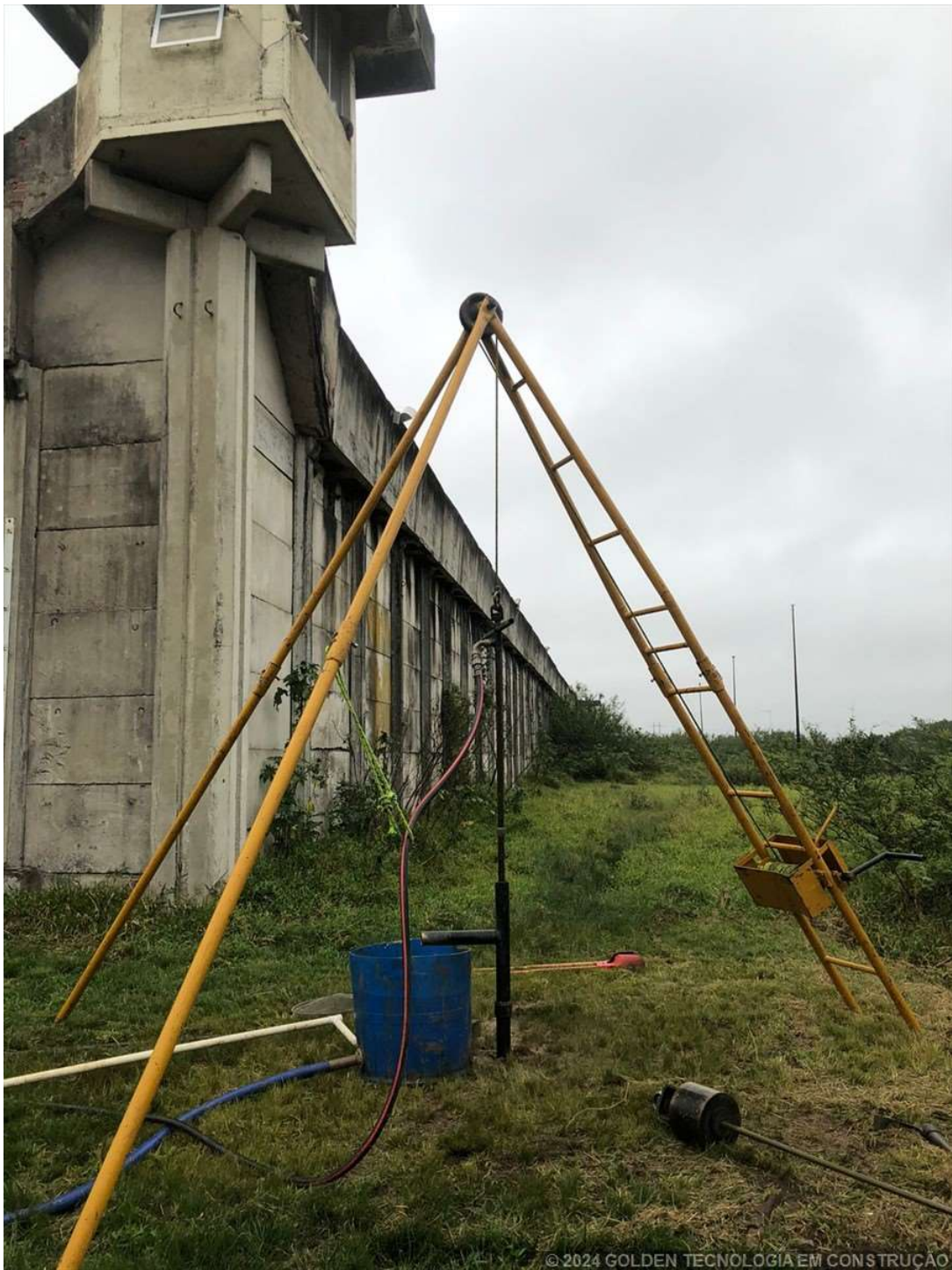
Foto 1 – SP 11 - ESTRADA AFONSO CARDOSO,2000,ZONA RURA - OSÓRIO-RS - 12.09.24
