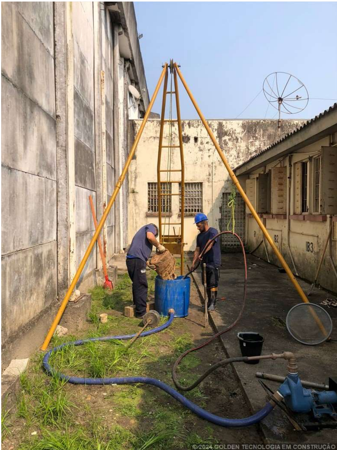
Foto 1 – SP 07 - ESTRADA AFONSO CARDOSO,2000,ZONA RURA - OSÓRIO-RS - 03.09.24
