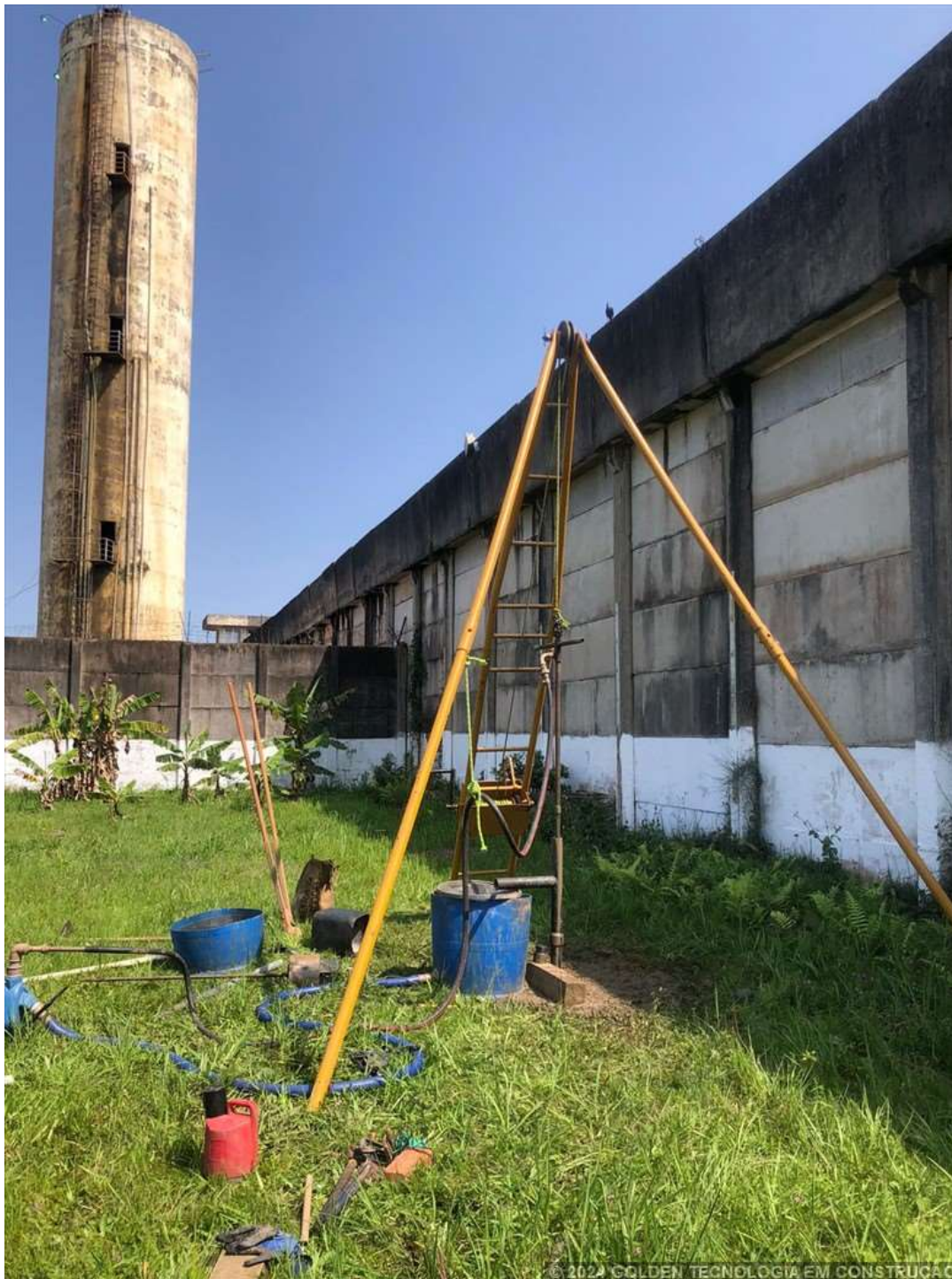
Foto 1 – SP 16 - ESTRADA AFONSO CARDOSO, 2000, ZONA RURA - OSÓRIO - RS - 19.09.24
