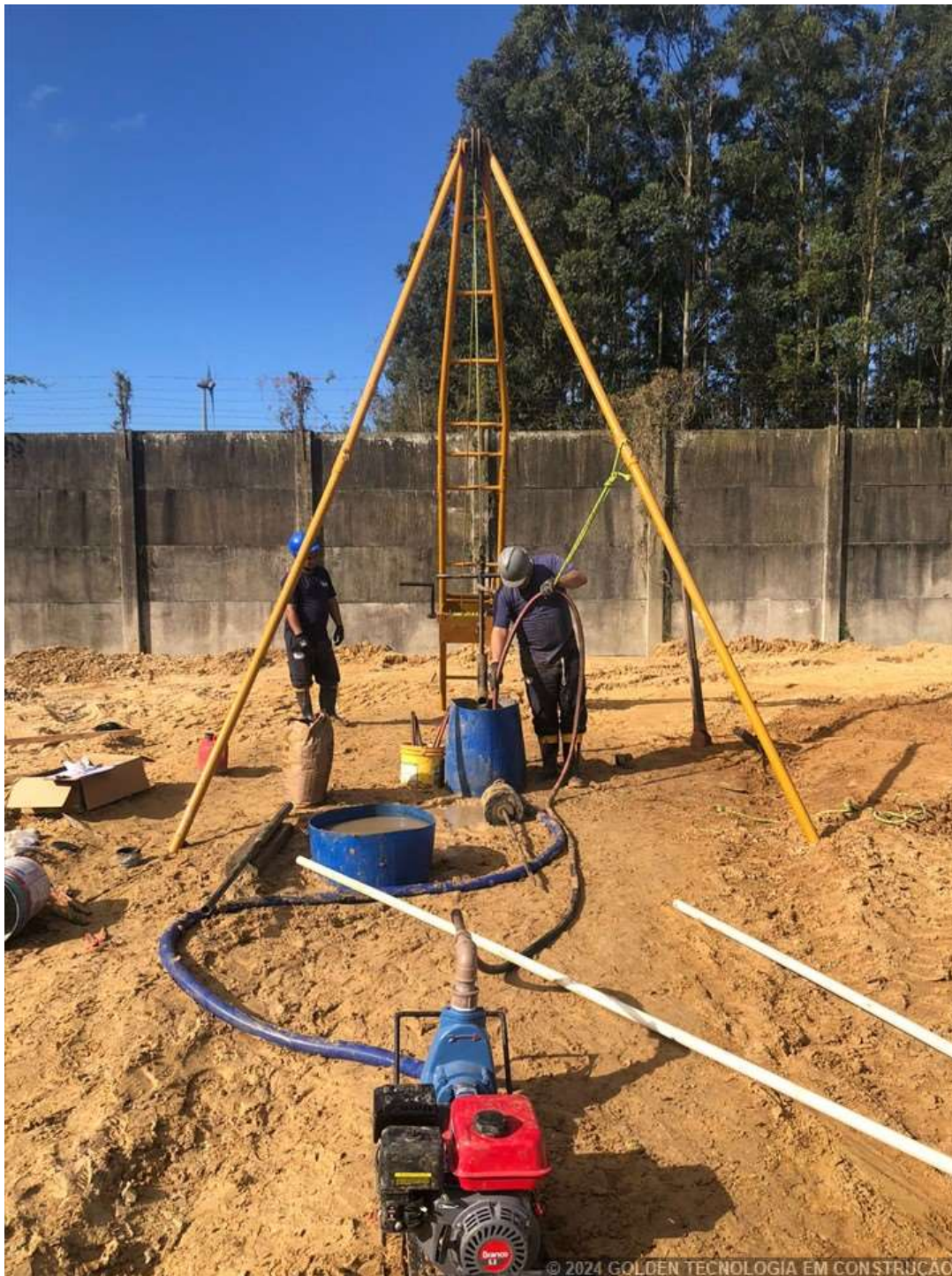
Foto 1 – SP 03 - ESTRADA AFONSO CARDOSO, 2000, ZONA RURA - OSÓRIO - RS - 27.08.24
