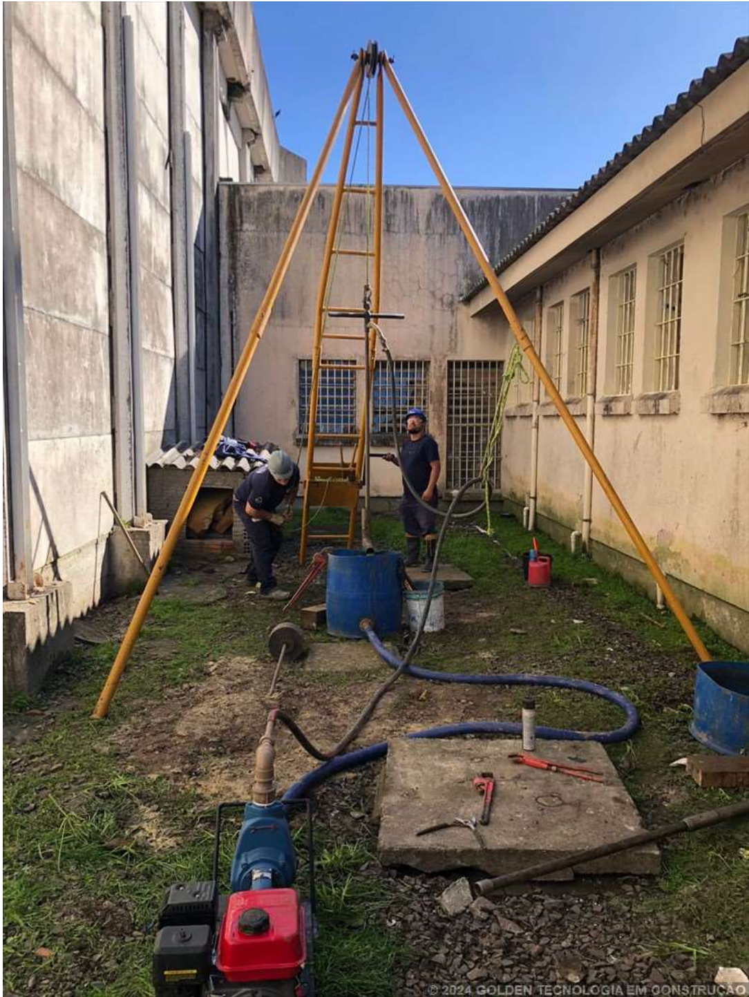
Foto 1 – SP 09 - ESTRADA AFONSO CARDOSO,2000,ZONA RURA - OSÓRIO-RS - 05.09.24
