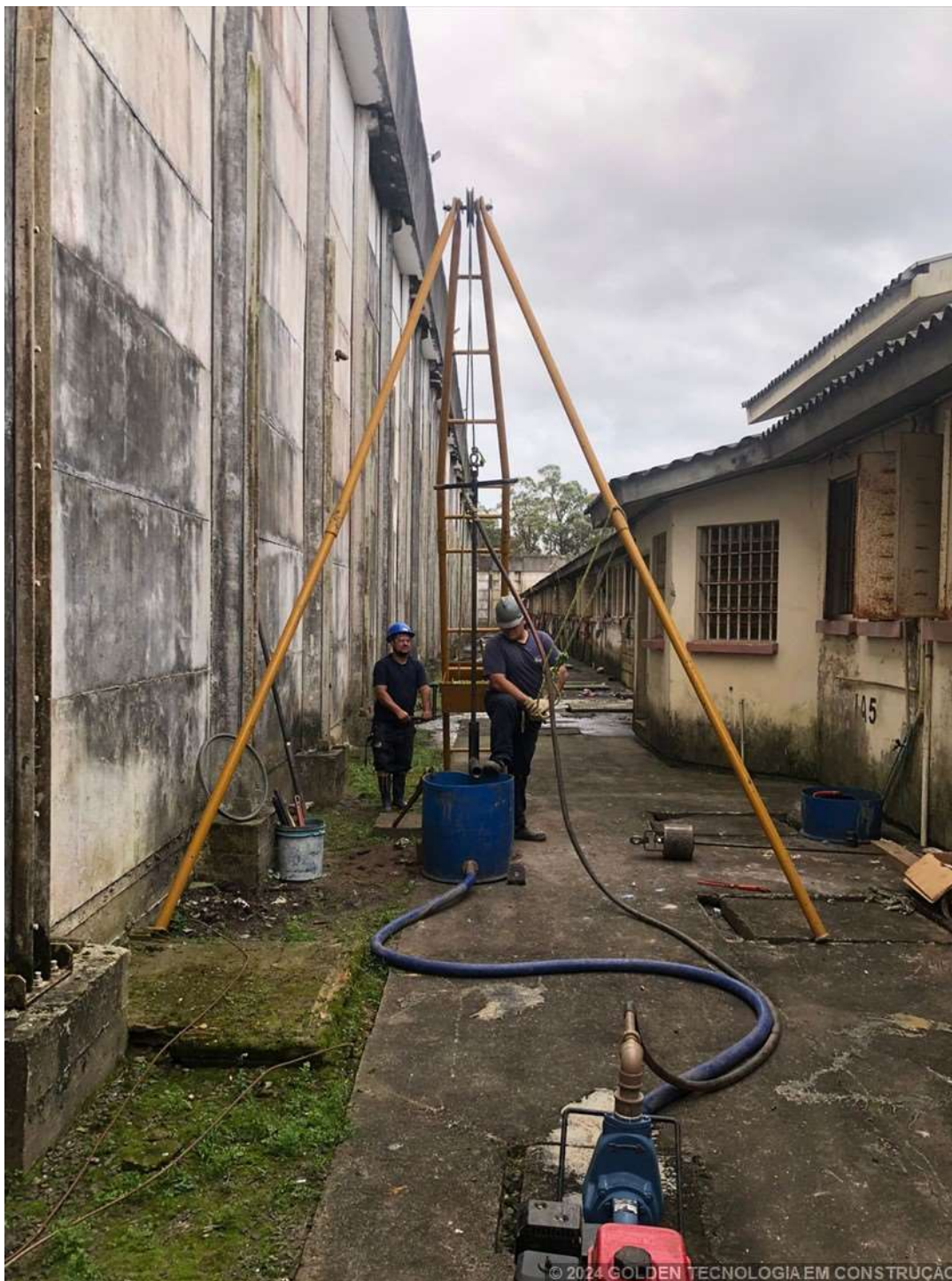
Foto 1 – SP 08 - ESTRADA AFONSO CARDOSO, 2000, ZONA RURA - OSÓRIO - RS - 04.09.24
