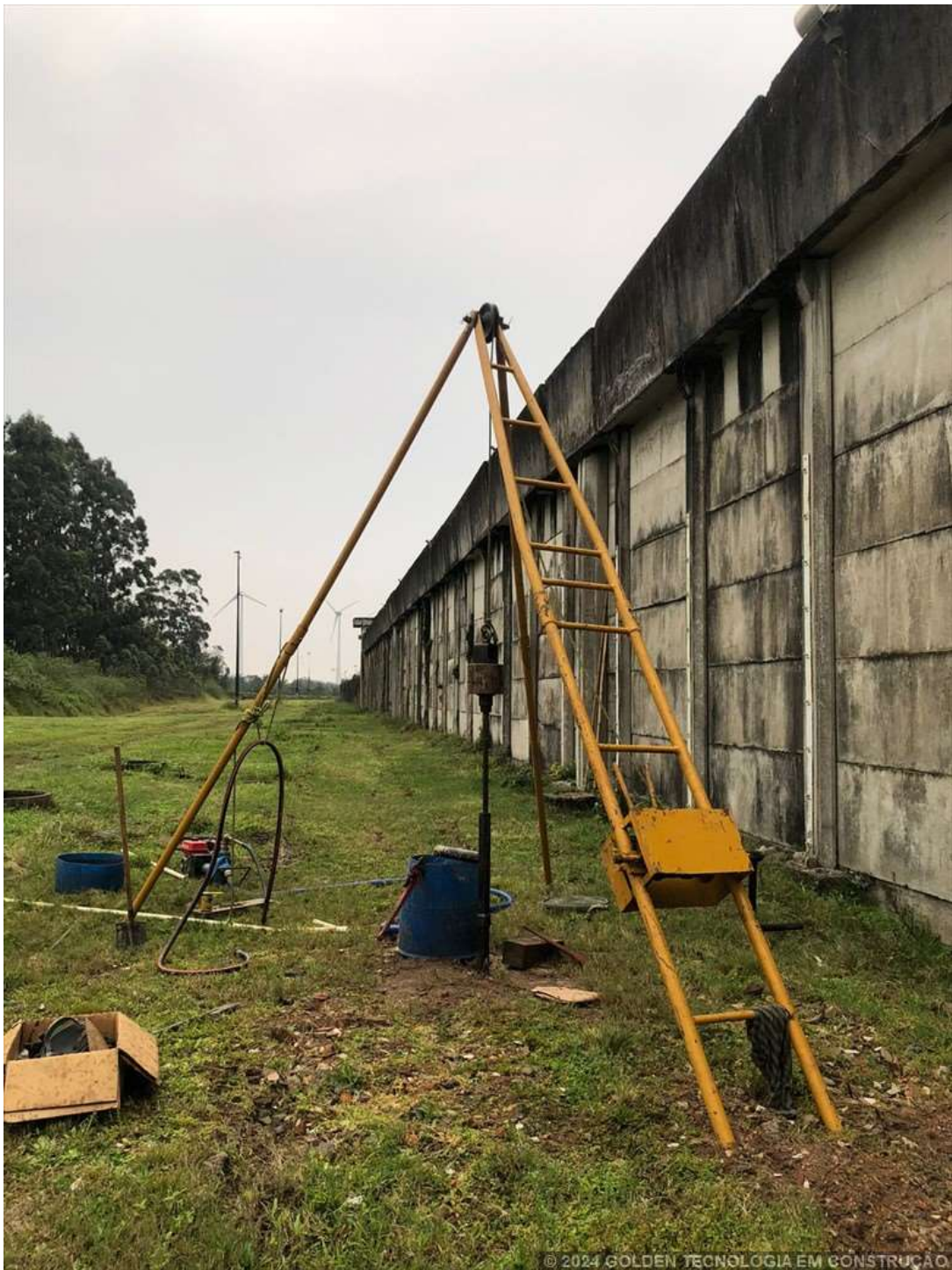
Foto 1 – SP 13 - ESTRADA AFONSO CARDOSO,2000,ZONA RURA - OSÓRIO-RS - 18.09.24
