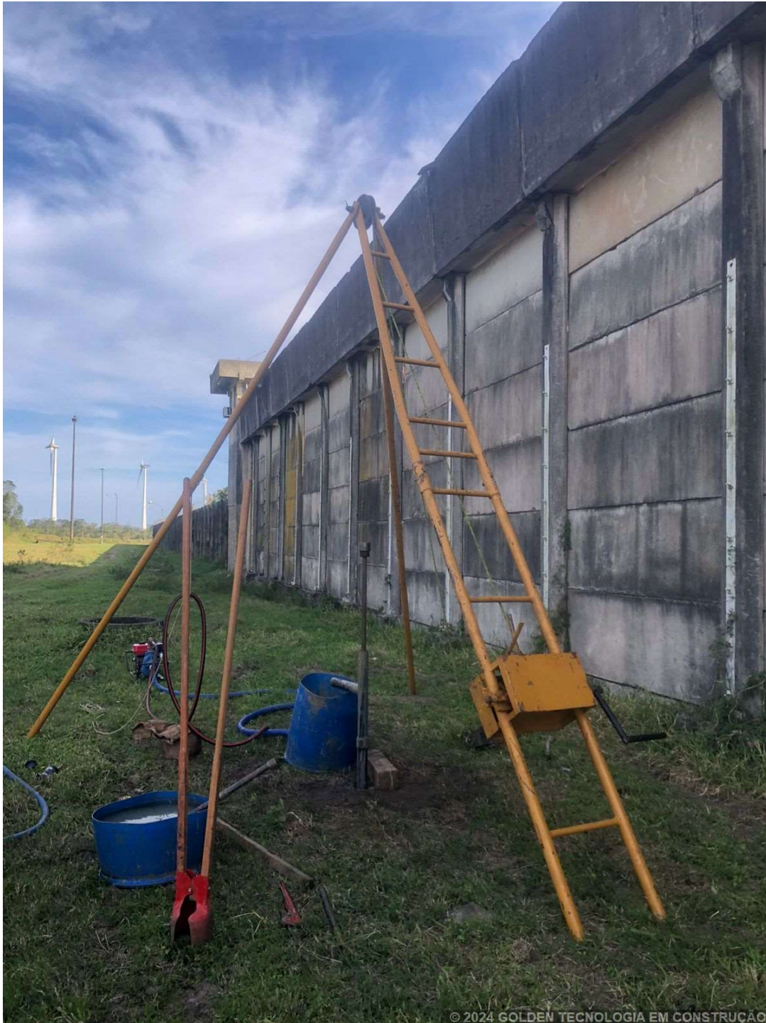
Foto 1 – SP 15 - ESTRADA AFONSO CARDOSO, 2000, ZONA RURA - OSÓRIO - RS - 19.09.24
