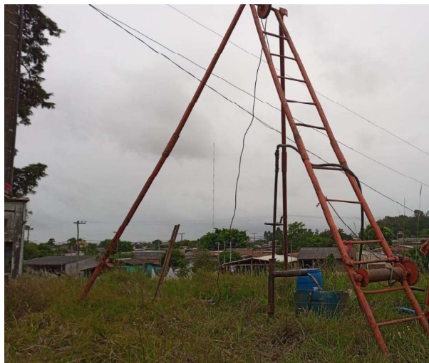
Foto 5. Tripé do SPT locado sobre o ponto de sondagem SP-11, pronto para ser executado.
