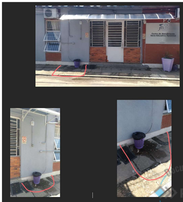
Local Para Instalar A Haste De Aterramento
