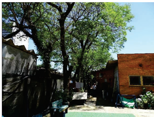
Foto 26. Detalhe dos troncos dos indivíduos 11 e 10 com projeção de copas em direção aos prédios que os cercam.
