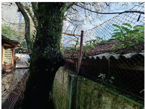
Foto 10. Indivíduo número 4 em proximidade com o muro com projeção de copa em direção ao telhado do prédio do CAFF.
