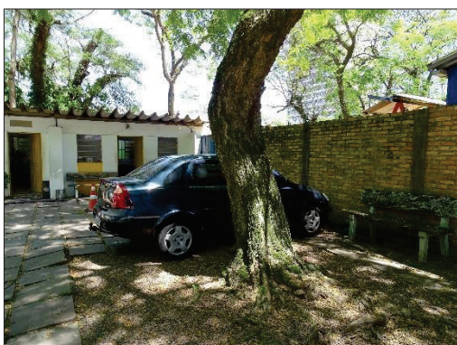
Foto 36. Raízes do indivíduo 15 danificando a calçada.
