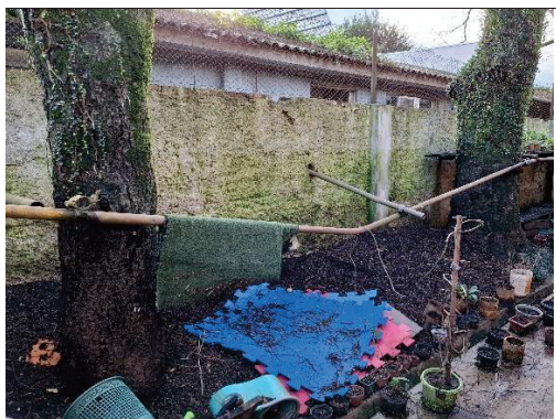
Foto 19. Vista do indivíduo 8 com projeção de copa em direção ao telhado do refeitório do CAFF.
