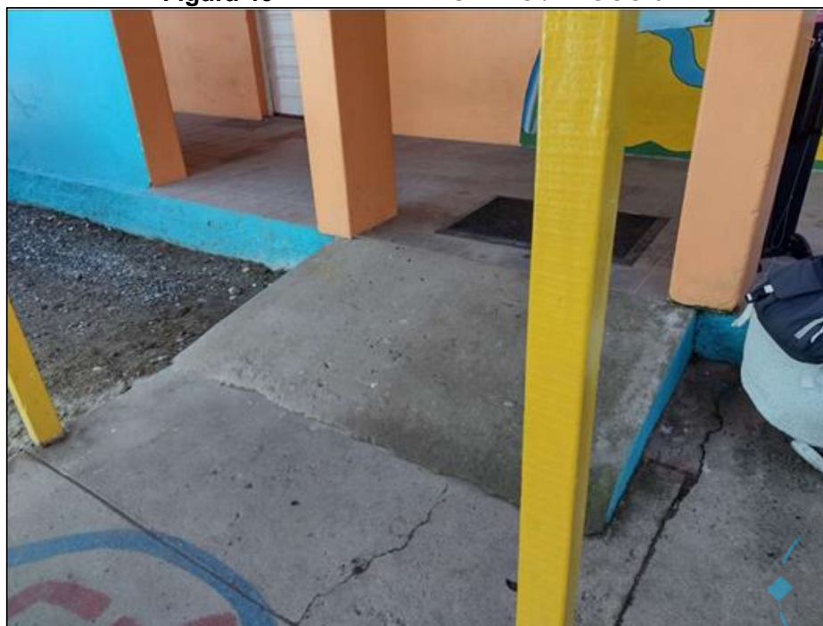
Figura 46 - RAMPA DE ACESSO / BLOCO 02
