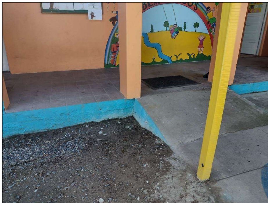
Figura 45 - RAMPA DE ACESSO / BLOCO 02
