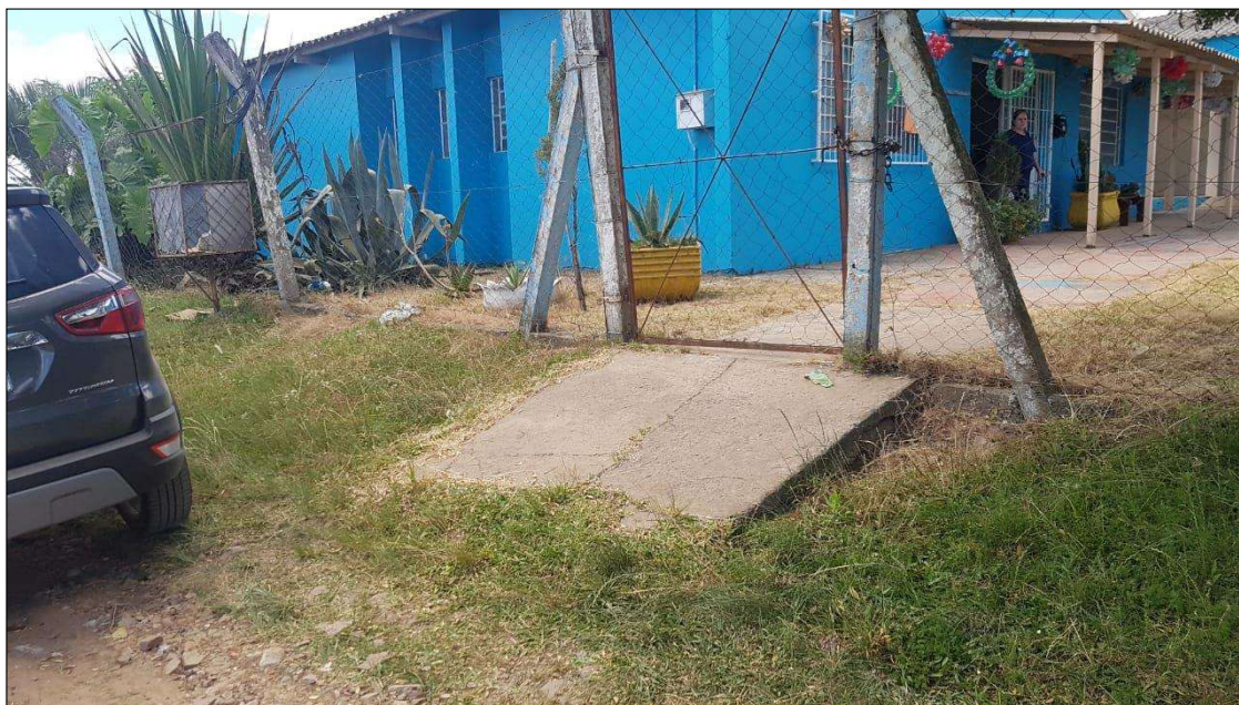
Figura 43 - RAMPA DE ACESSO ESCOLA
