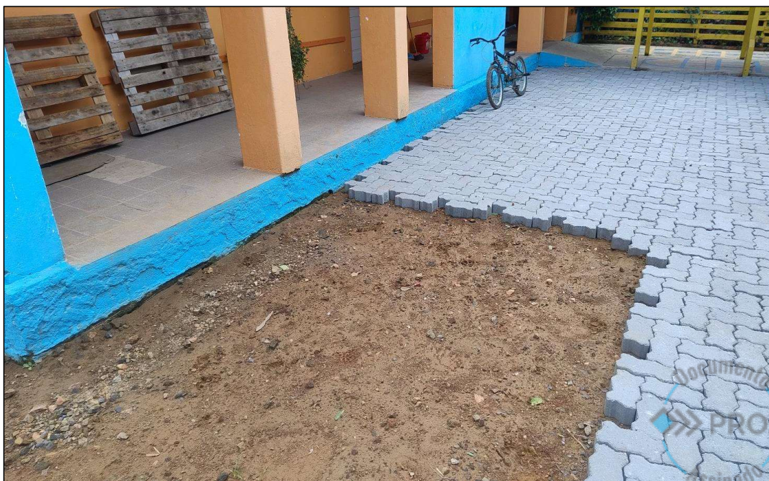
Figura 48 – DEGRAU ISOLADO / BLOCO 02
