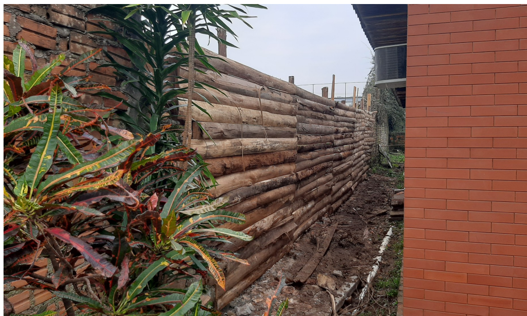
Figura 1 – Vista da divisa sul com cercamento provisório no lugar do muro.
