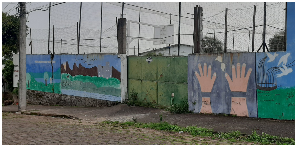
Figura 2 – Vista do muro da divisa leste.
