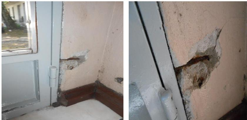
Concreto Desplacado com Armadura Corroída
