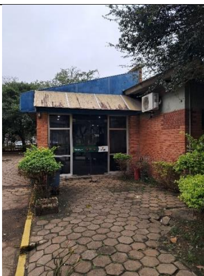
Imagem 1: Entrada da Recepção.
