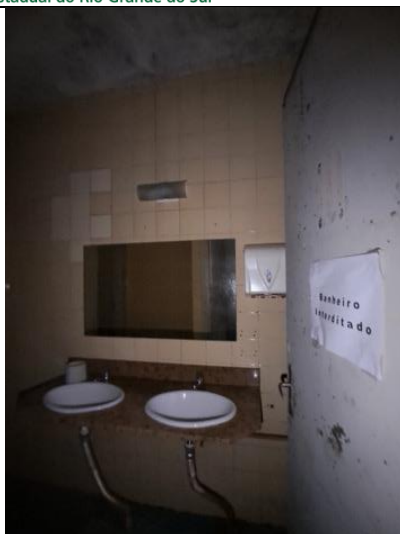
Imagem 27: Sanitário Refeitório Feminino.
