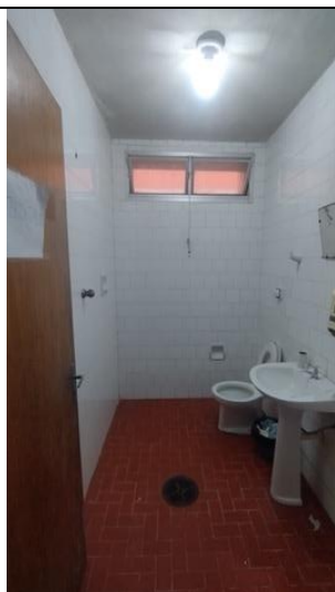
Imagem 11: Sanitário Acessível Feminino.
