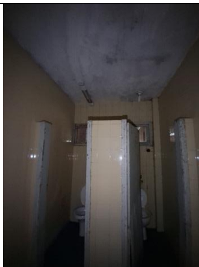
Imagem 28: Sanitário Refeitório Feminino.
