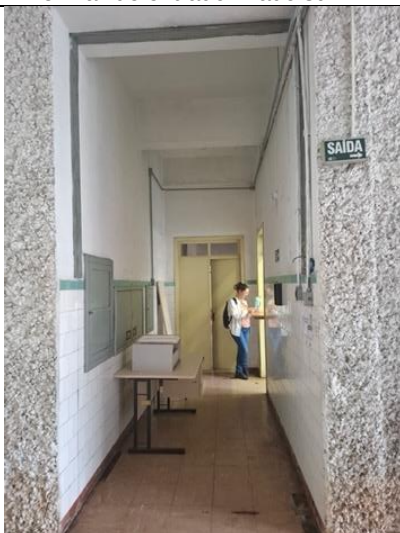
Imagem 17: Circulação – lado sul.
