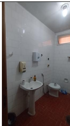
Imagem 12: Sanitário Acessível Masculino.
