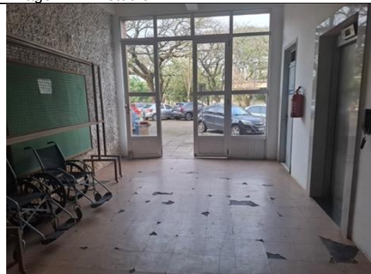
Imagem 16: Hall de entrada – lado sul.
