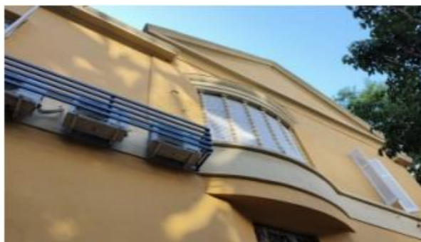
Figura 2 – Modelo de grades já instaladas na edificação
