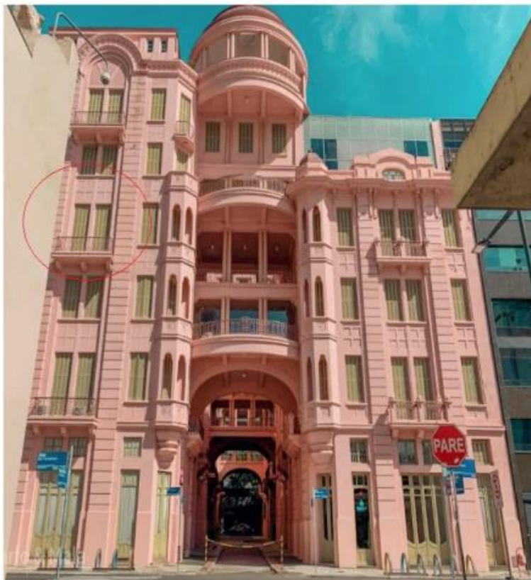
Figura 2 - localização unidade condensadora, na sacada externa
