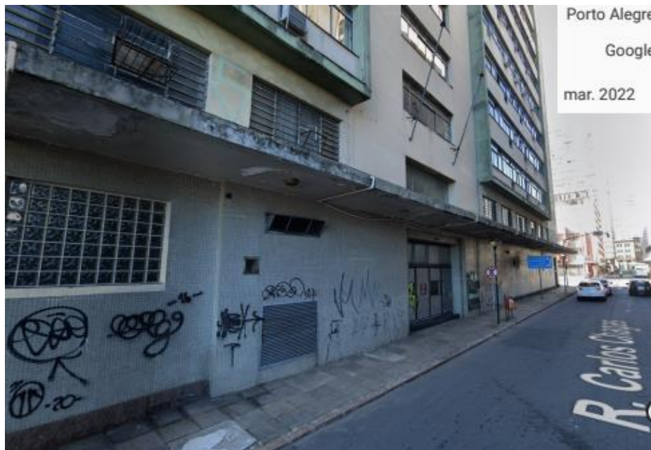
Foto 1 – Fachada pela Rua Carlos Chagas.
