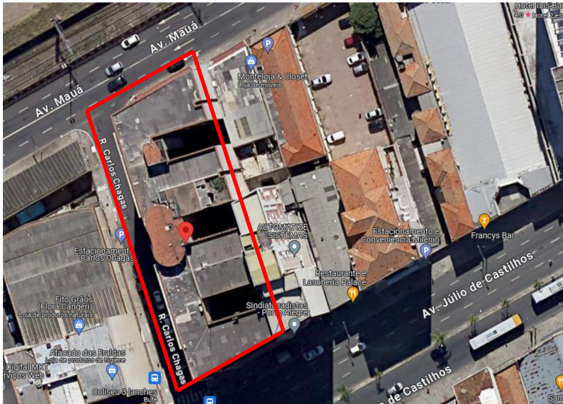
Figura 1 – Identificação do Edifício Othelo Rosa pelo Google Earth.
