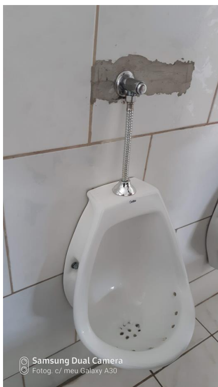
Figura 01: todos os mictórios do sanitário masculino de alunos estão comprometidos: 2 deles desativados por vazamento e os outros 3 com válvulas estragadas;
