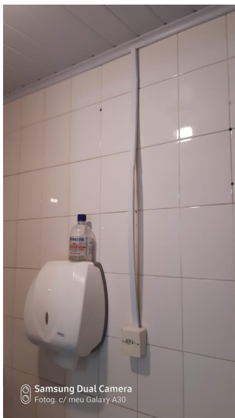
Figura 05 e 06: circuito da tomada é o mesmo da iluminação;
