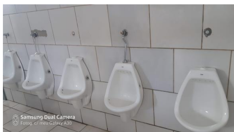
Figura 01: todos os mictórios do sanitário masculino de alunos estão comprometidos: 2 deles desativados por vazamento e os outros 3 com válvulas estragadas;
