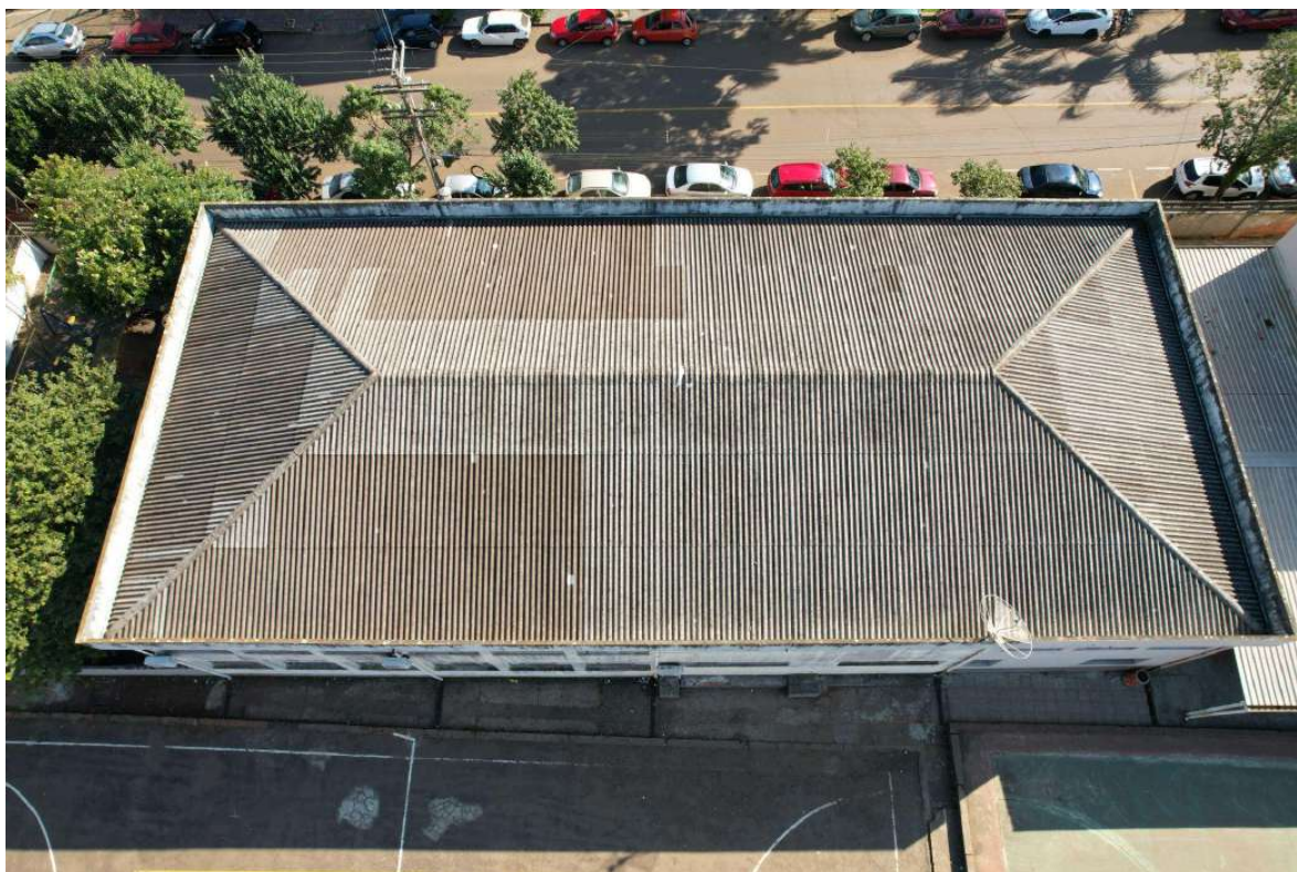
Figura 11- Cobertura do Bloco 3.
