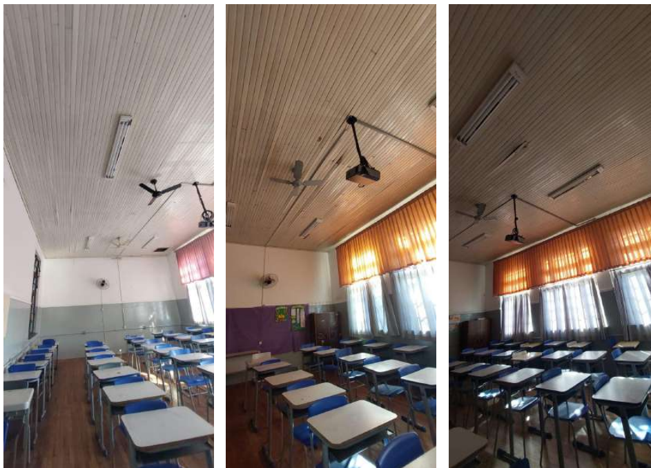
Figura 4 - Imagens do forro de madeira das Salas de Aula no Bloco 01.
