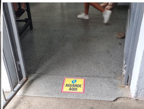
Foto 9: Desnível refeitório existente (bloco A) e pátio
