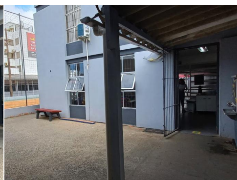
Foto 5: Pátio descoberto e fundos do bloco A
