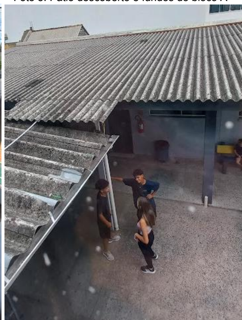
Foto 7: Pátio descoberto e bloco B
