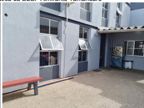
Foto 3: Pátio descoberto e fundos do bloco A
