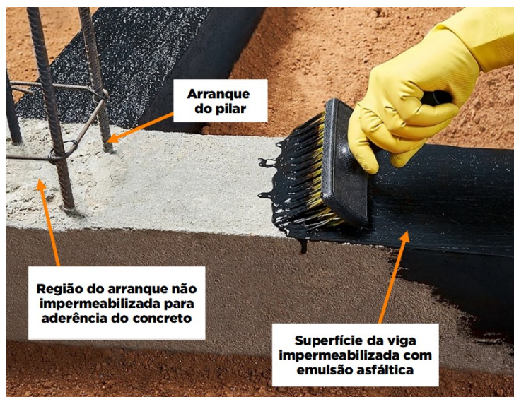
Figura 11 - Impermeabilização de viga baldrame com emulsão asfáltica.
