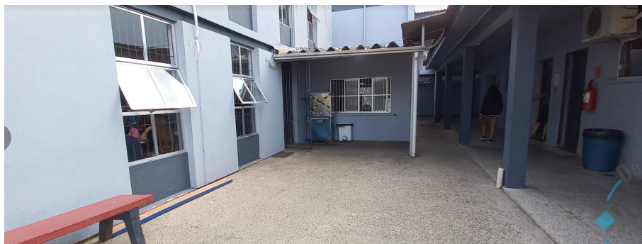
Figura 1 – Local onde será realizada a ampliação do refeitório, entre o bloco 2, a direita, e o bloco 3, a esquerda (foto de 03/2023).
