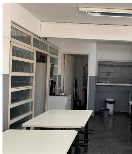
Figura 9 – Porta PE3 existente a ser alterada para porta de giro com abertura de 180° (foto de 03/2023).
