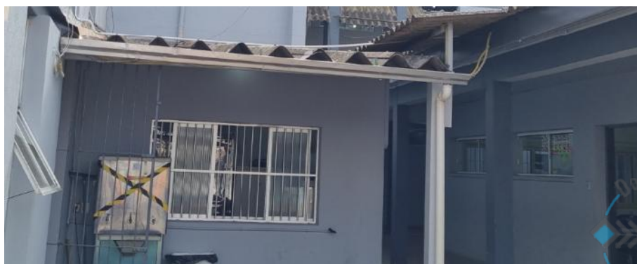
Figura 4 – Cobertura ligação bloco 2 e bloco 3 e cobertura cozinha a ser substituída (foto de 03/2023).
