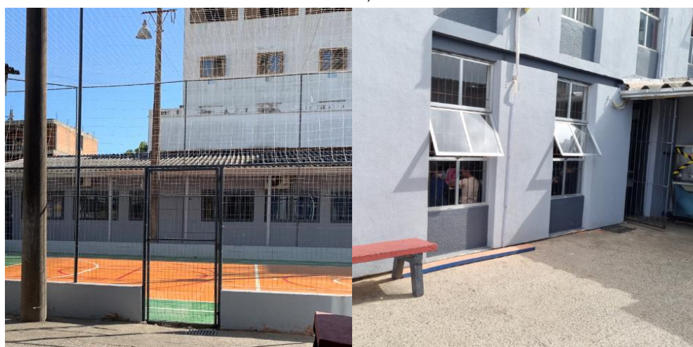
Figura 6 – Portão quadra de esportes a ser isolado durante a execução da obra e postes a serem removidos (foto de 11/2022).
