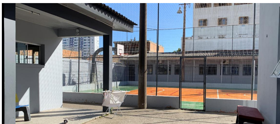
Figura 2 – Local onde será realizada a ampliação do refeitório, entre o bloco 2, a esquerda, e o bloco 3, a direita (foto de 11/2022).
