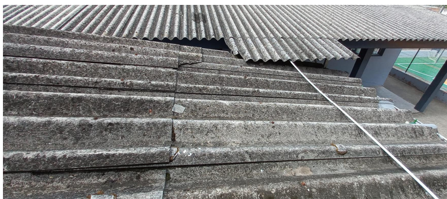
Figura 5 – Cobertura ligação bloco 2 e bloco 3 e cobertura cozinha a ser substituída (foto de 03/2023).
