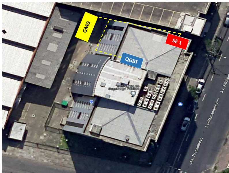
FIGURA 1 - Ilustração dos locais de instalação do GMG, do QGBT e da Subestação 1 no Prédio Sede da Secretaria da Segurança Pública.
