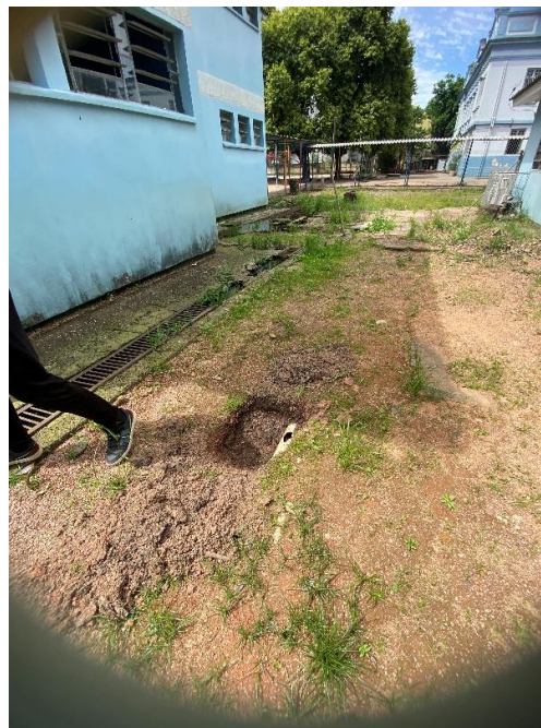
Registro 06: Tubulação exposta.
