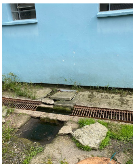
Figura 05 – detalhe das caixas, sem tampa
