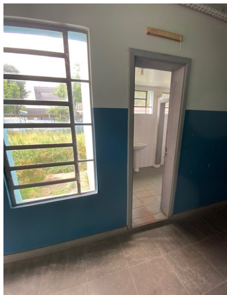
Figura 07 – vista do banheiro térreo
