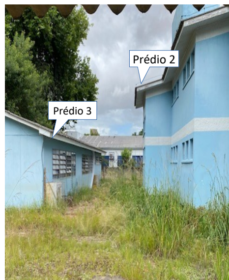
Figura 03 – área entre os prédios 2 e 3
