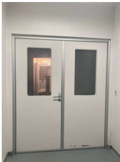
Porta existente área interna a se mantida
