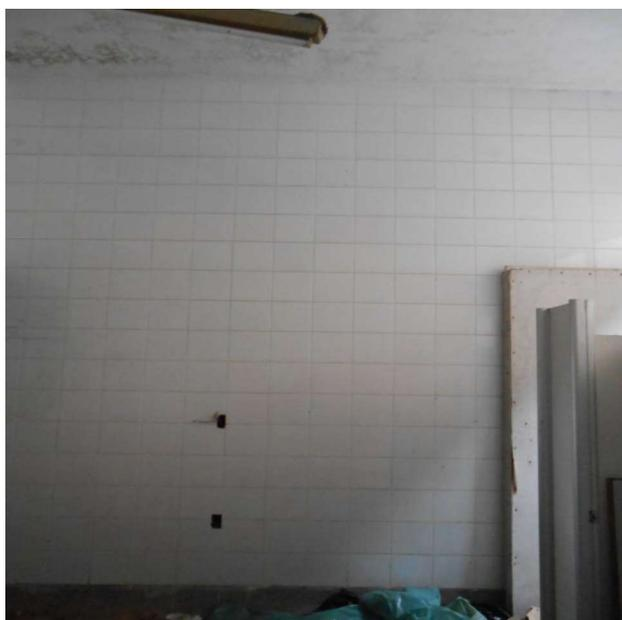
2d – Parede Lateral – Manchas de Umidade e Bolor no Teto.
