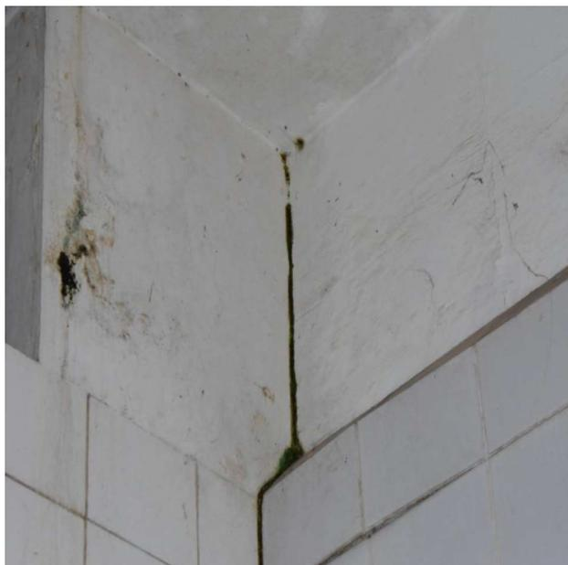
12f – Sujidades, Umidade e Bolor na Parede e nas Placas Cerâmicas.
