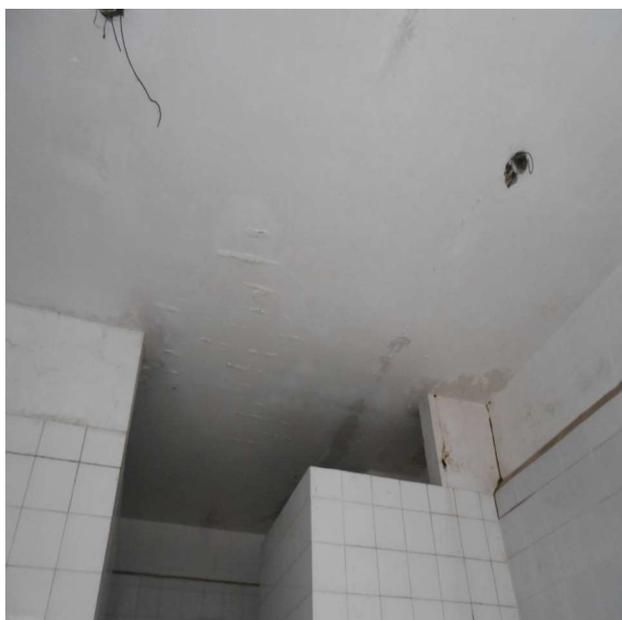
12g – Pintura Descamada e Manchas de Umidade na Laje.
