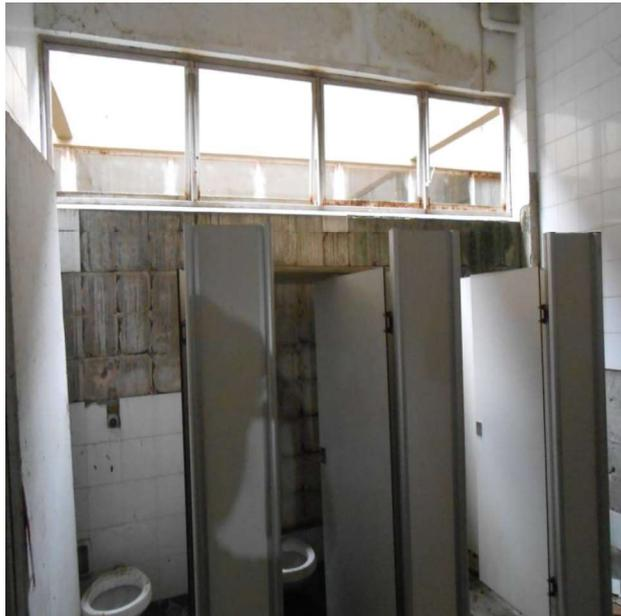
2e – Manchas de Umidade e Cerâmicas Desplacadas.
