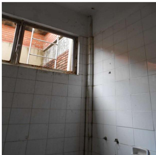
12d – Sujidades, Umidade e Bolor na Parede e nas Placas Cerâmicas.
