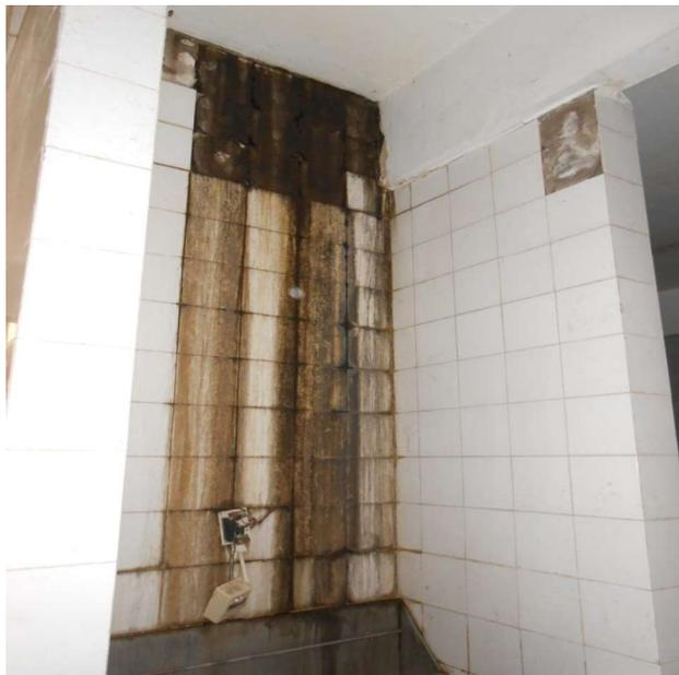
12i - Sujidades, Umidade e Bolor na Parede e nas Placas Cerâmicas. Placas Cerâmicas Desplacadas.
