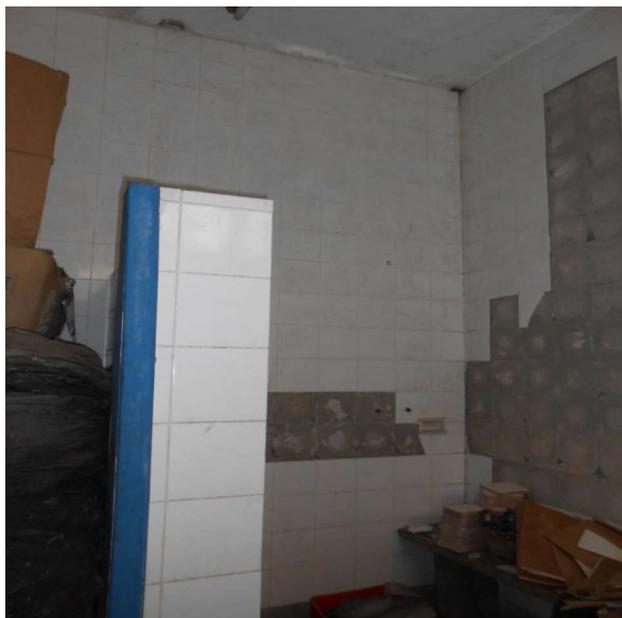
3e – Cerâmicas Desplacadas na Parede.
