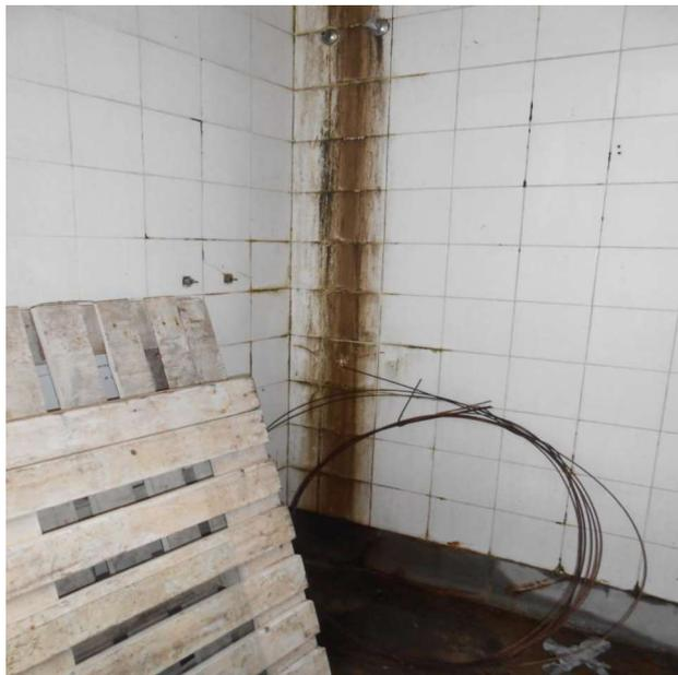
12c – Sujidades, Umidade e Bolor na Parede e nas Placas Cerâmicas.
