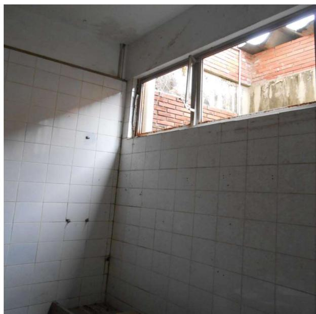
12e – Sujidades, Umidade e Bolor na Parede e nas Placas Cerâmicas.
