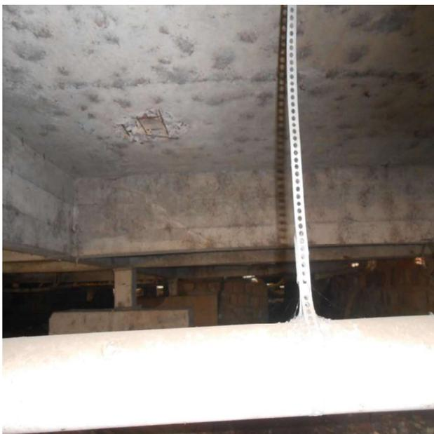
1h – Armadura Exposta e Concreto Segregado na Laje.
