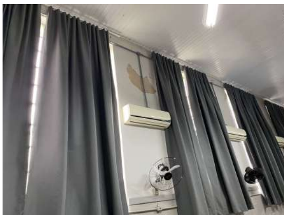
Foto 12 - Revestimento das paredes danificadas.
