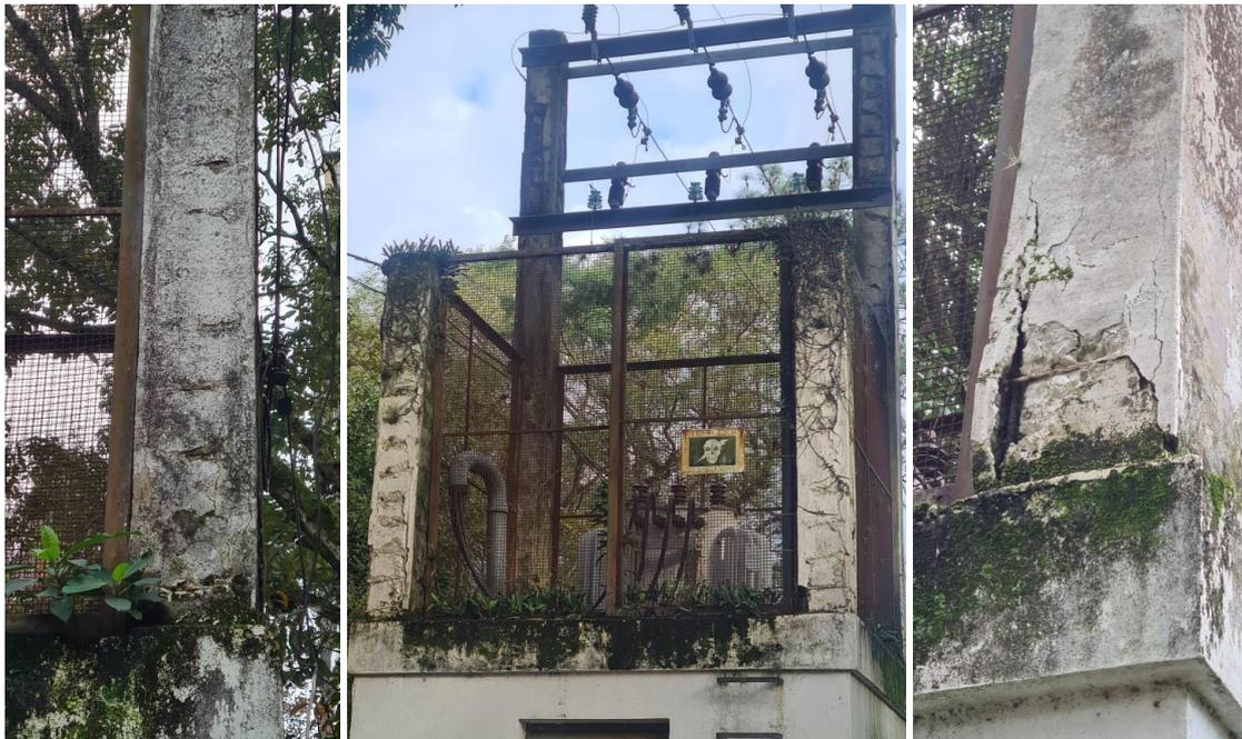
Imagem 02: Pilares de alvenaria para ancoragem e fechamento - SE-02
