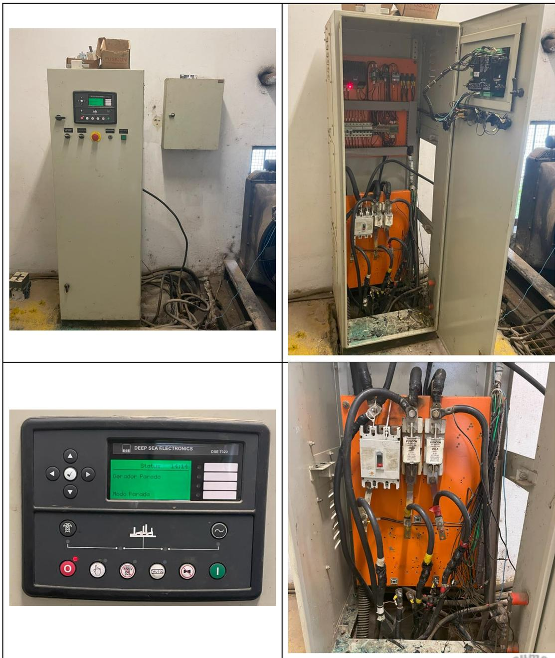
Imagem 1: Grupo Gerador de energia elétrica à diesel.
