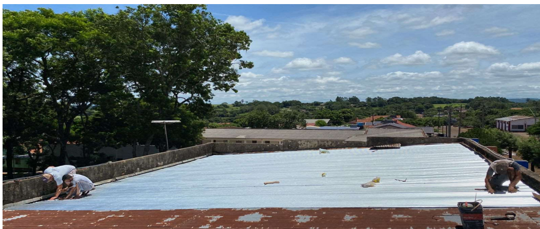
Substituição de telha executada pelo Agiliza
