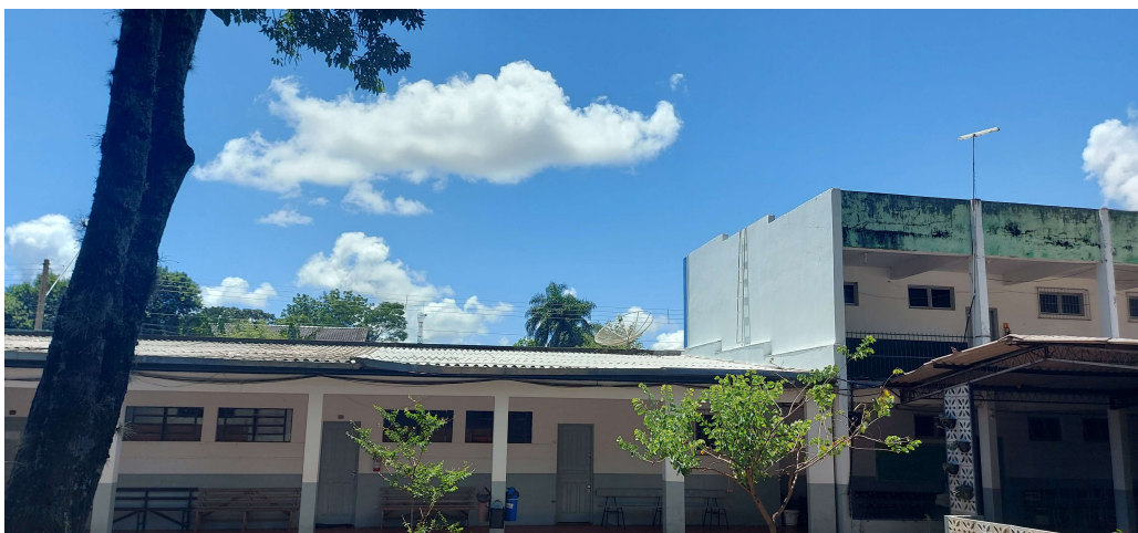
Substituição de telha executada pelo Agiliza
