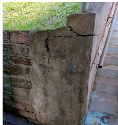
F02: Pilarete/Rachaduras
