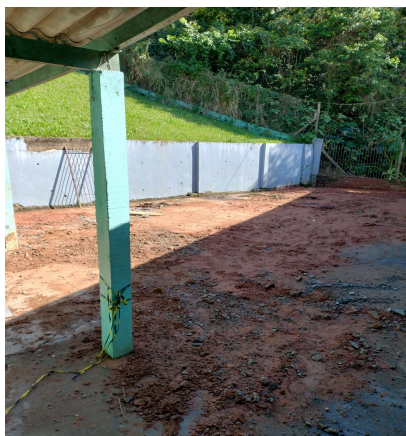
F01: Pátio/Calçada em execução
