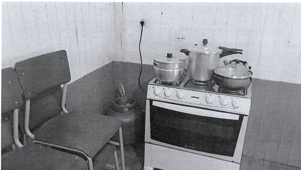
Figura 5: BOTIJÃO DE GÁS PRÓXIMO AS SALAS COM PAREDES DE MADEIRA
