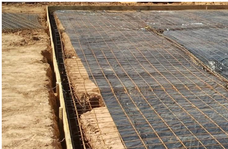
Figura 9 - Impermeabilização de solo sob laje com manta PEAD.
