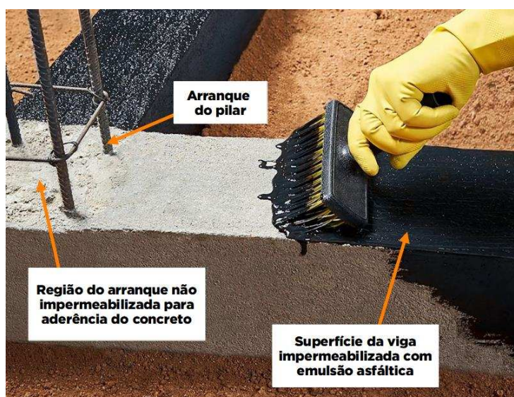
Figura 8 - Impermeabilização de viga baldrame com emulsão asfáltica.
