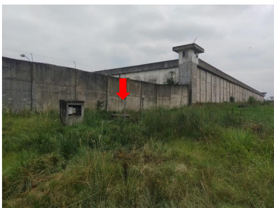
Figura 01: Poço de recalque.
