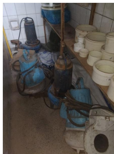
Figura 02: Bombas danificadas.
