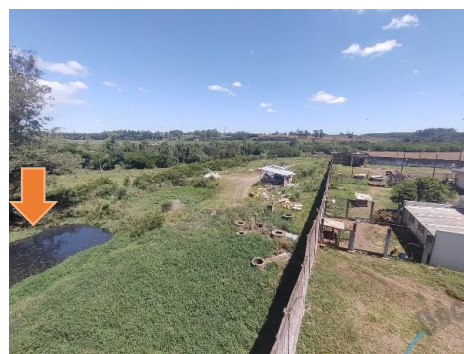
Figura 04 – Situação da penúltima lagoa de tratamento de esgoto (ativa).
