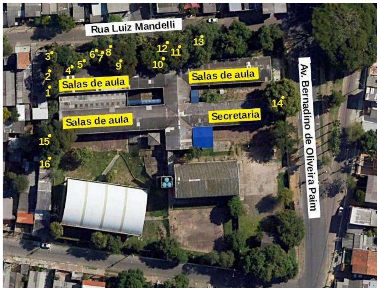
Figura 1. Mapeamento da escola com destaque para as árvores a serem suprimidas.
