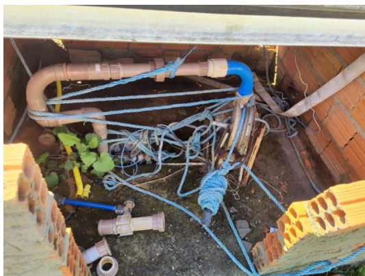
Casa de bombas de captação de água subterrânea
