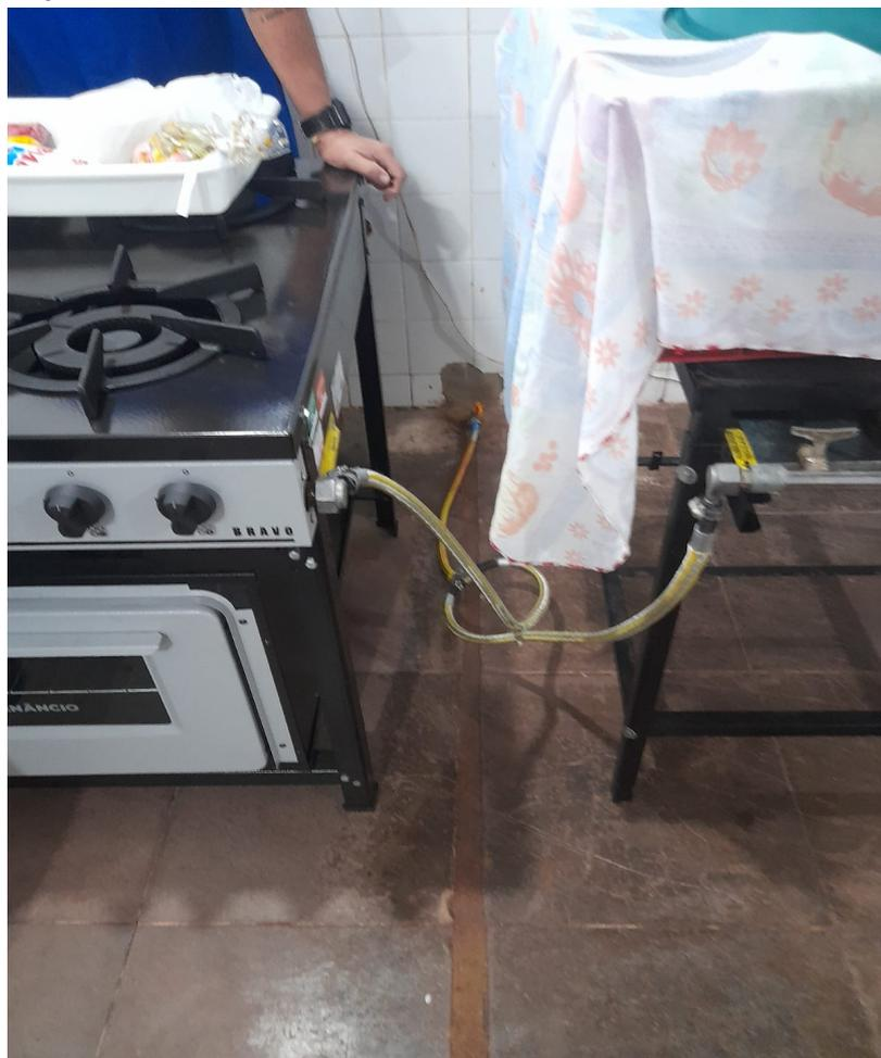
Foto 1: Foto mostra a saída do gás com registro do gás no chão com mangueiras soltas desconforme conforme normas de gás
