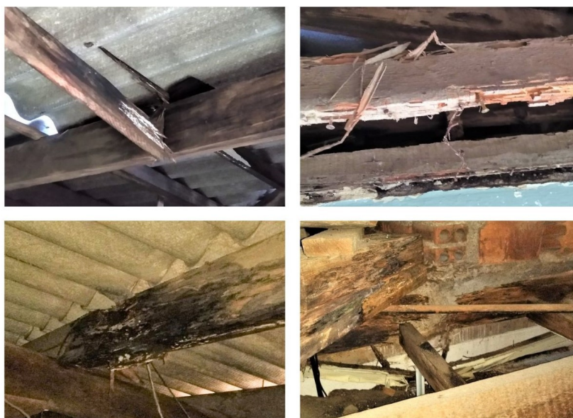
Figura 5: Estado atual da estrutura de madeira do telhado.
