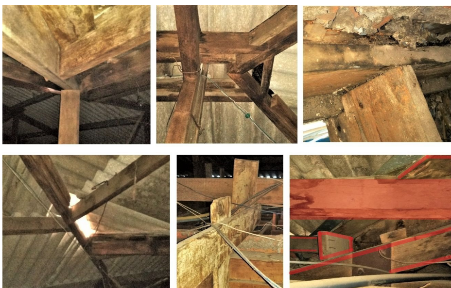
Figura 6: Elementos construtivos do madeiramento do telhado.
