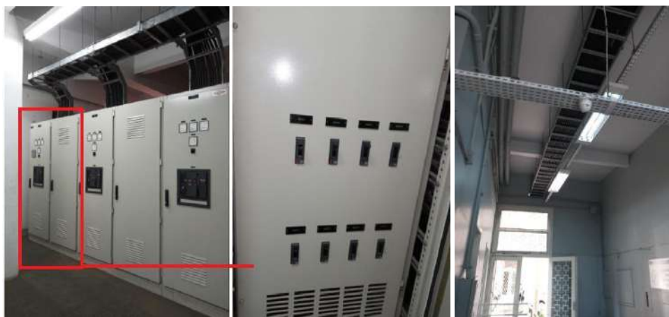
Figura 2 – Detalhes das características construtivas e dispositivos de proteção instalados no QGF, responsável pela entrega de energia para o quadro elétricos do 3º pavimento.
