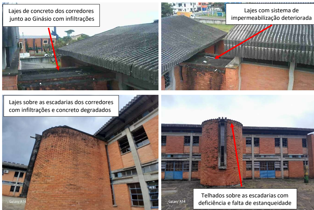
Figura 08 – Imagens das lajes dos corredores e das escadarias – lado externo
