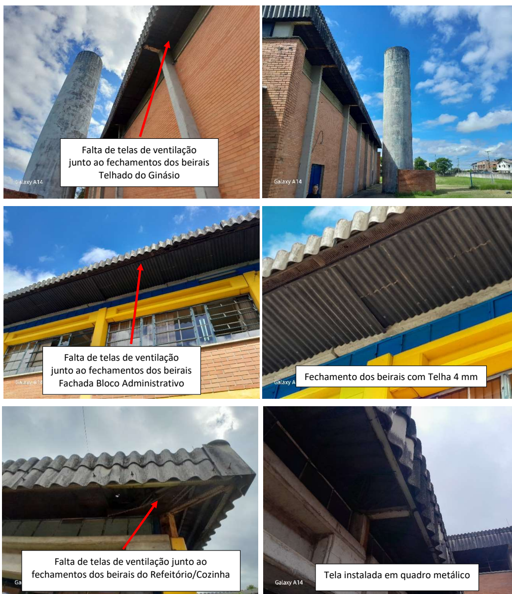
Figura 10 – Imagens Estado atual do Sistema de Cobertura
