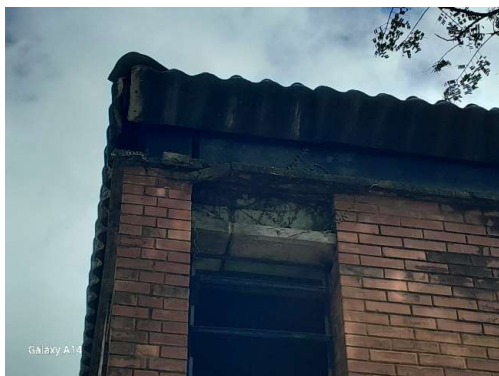
Processo de delaminação da cerâmica constituente dos tijolos
