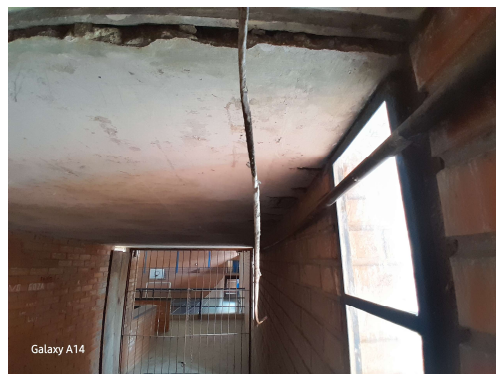
Laje com Impermeabilização deficiente
