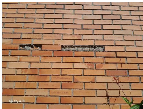
Deterioração dos tijolos cerâmicos e formação de eflorescências nas paredes
