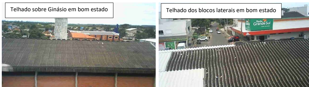
Figura 09 – Imagens dos telhados
