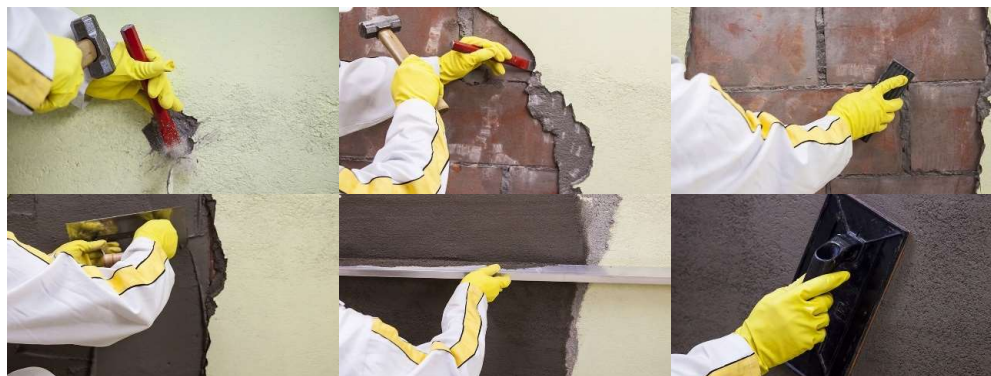
Figura 04 – Recuperação de Revestimentos de Reboco – imagens ilustrativas
