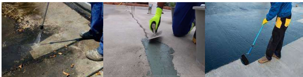
Figura 05 – Procedimento de impermeabilização da laje – imagens ilustrativas
