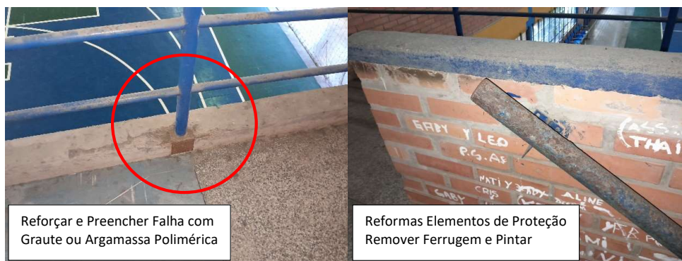
Figura 09- Imagens do Guarda-corpo e Corrimões
