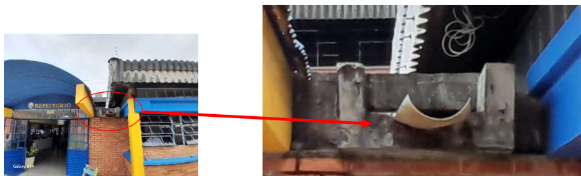
Figura 06 – Fotos da viga-calha
