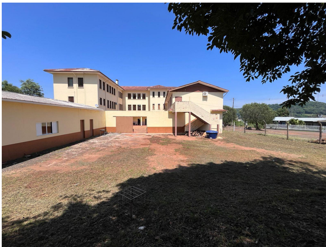
Foto 01 – Pátio e fachada
