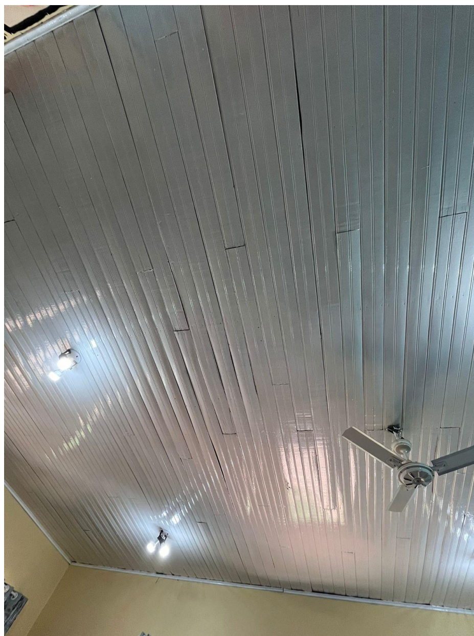
Foto 12 – Forro sala de aula
