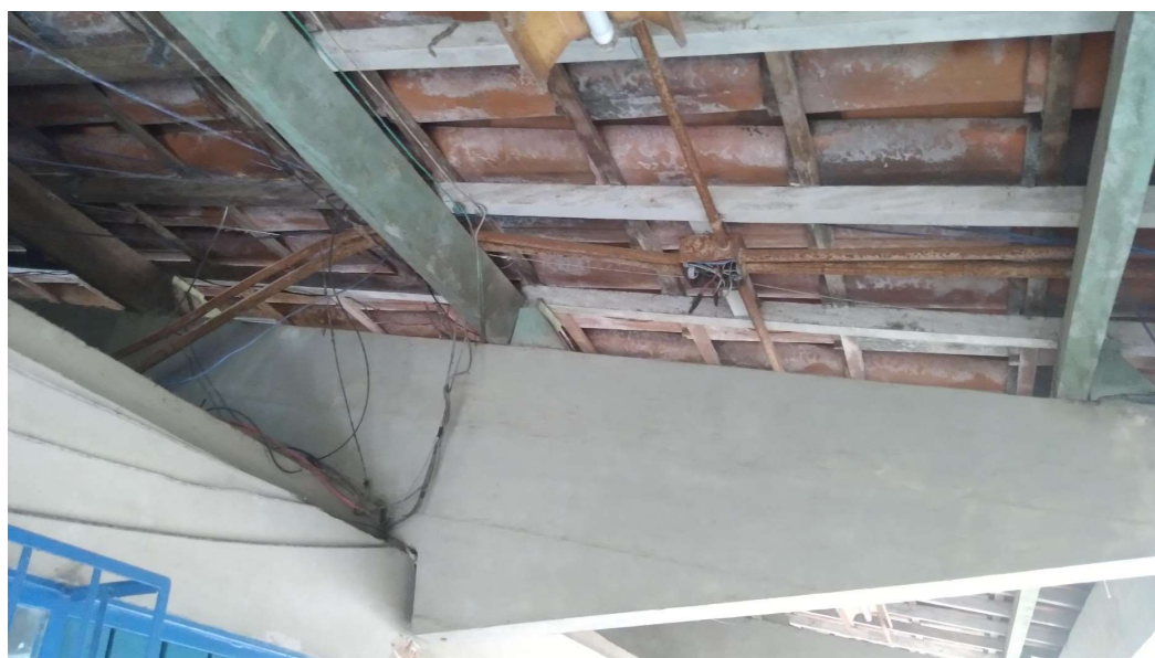
Foto 08 – oxidação dos eletrodutos existentes
