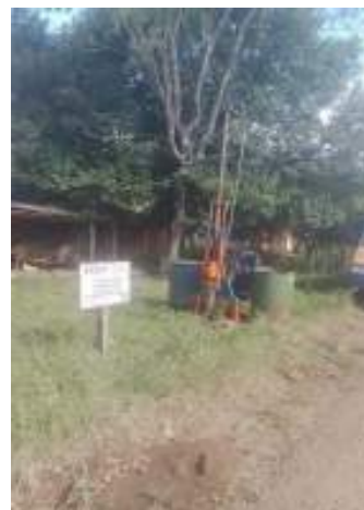
Sondagem SR-03 (km 15+640)
