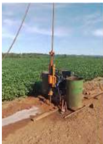
Sondagem SR-01 (km 2+760)
