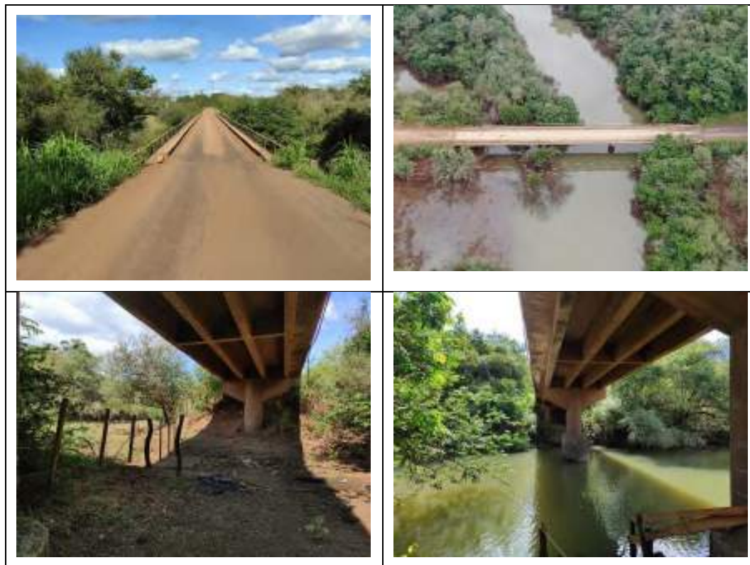
Figura 2.4.19 – Fotografias da vistoria de campo.
