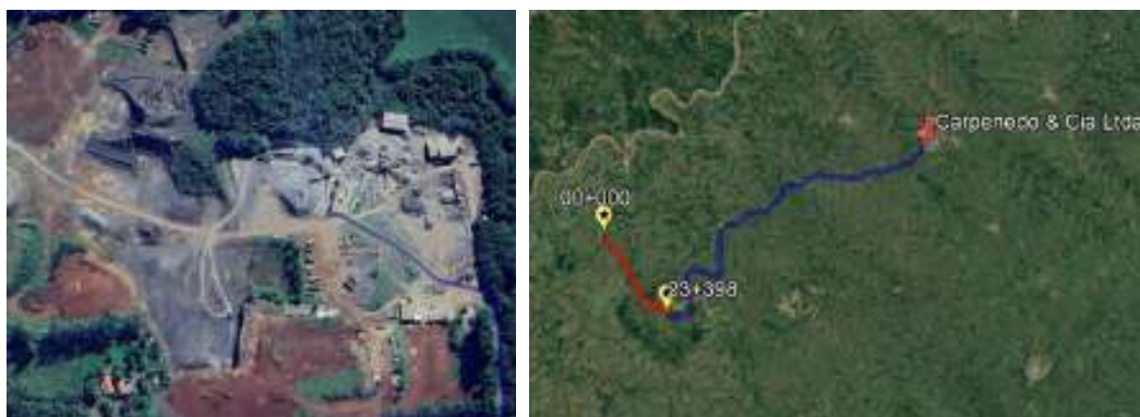
Figura 2.5.17 – Imagem de satélite e localização da Pedreira Carpenedo LTDA.
