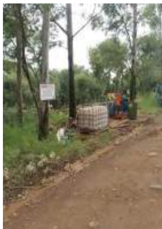
Sondagem SR-02 (km 10+960)
