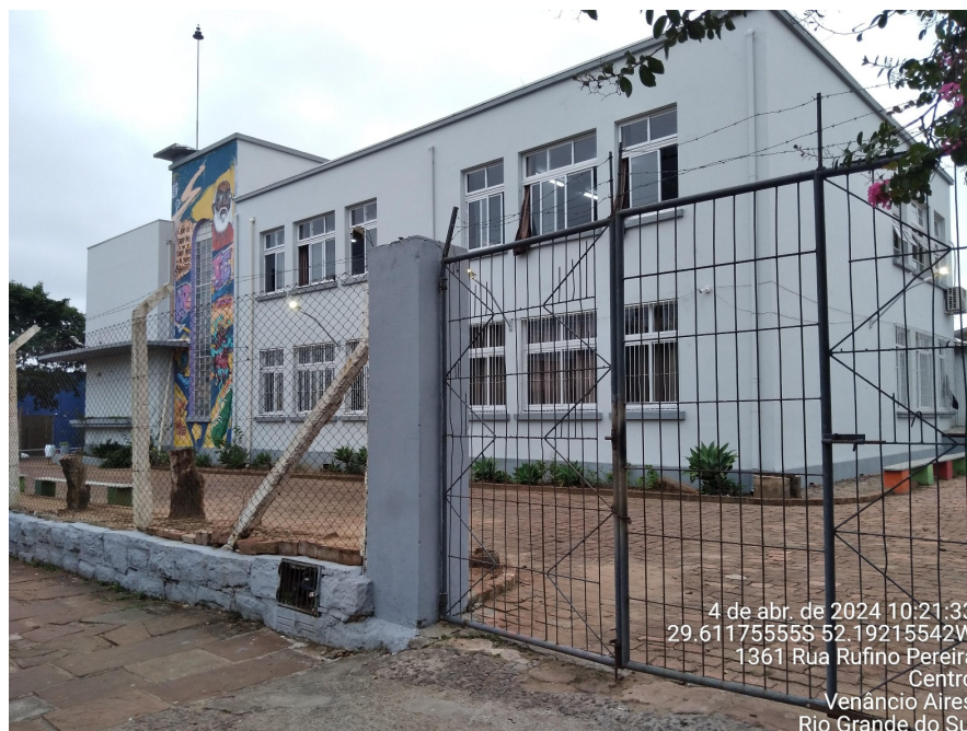
Foto 01 – localização prevista para implantação de subestação e QGBT
